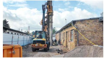
Mittels Bodenaustauschbohrungen werden belastete Bereiche zunächst ausgekoffert.
