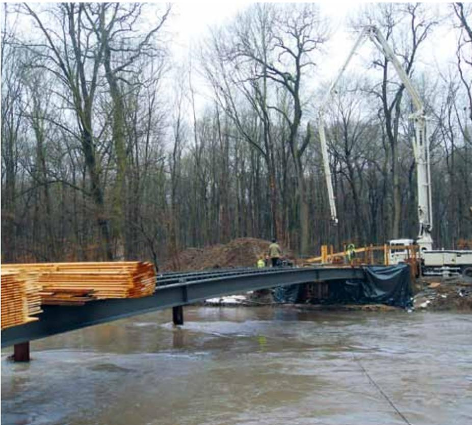
Leipzig. Trotz der lang anhaltend kalten Winterwitterung sind die Bauarbeiten an der Brücke Probsteisteg in unmittelbarer Nähe zur Schleuse Connewitz wie geplant weitergelaufen. Für den Ersatzneubau wurden noch vor Weihnachten Stahlträger montiert. Derzeit erfolgt die Betonierung der Widerlager. ■
