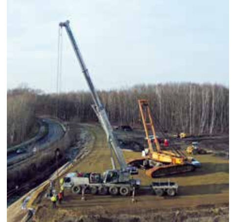
Anfang Februar wurde das raupengestützte Trägergerät für die Verdichtungsarbeiten aufgebaut.
