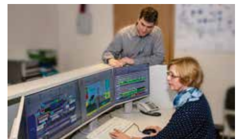
Abstimmen des Flutungsgeschehens in der Flutzentrale Lausitz
