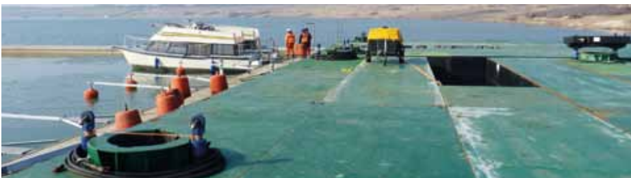
Zusammengefügte Arbeitspontons auf dem Concordiasee am Anleger Schadeleben.
