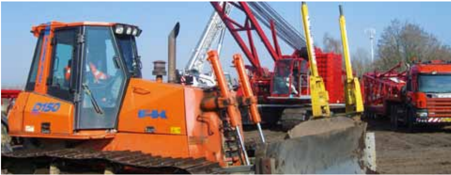
Am Silbersee wird eines der Rüttelstopfverdichtungsgeräte aufgebaut.
