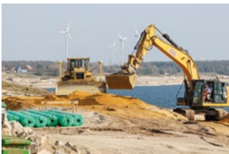
Ausformung des Hafenbeckens für den künftigen Wasserwanderastplatz
