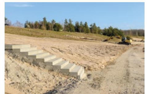
Profilierung von Böschungen und Errichtung von Treppenanlagen für den Seestrand Lieske
