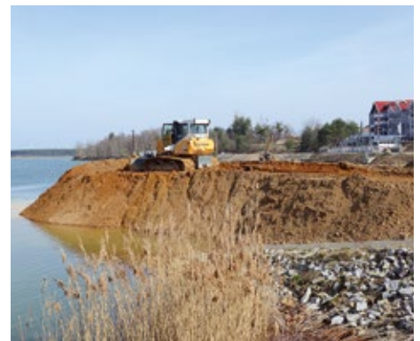
Die Sanierungsarbeiten an der Südböschung des Geierswalder Sees gehen voran.
