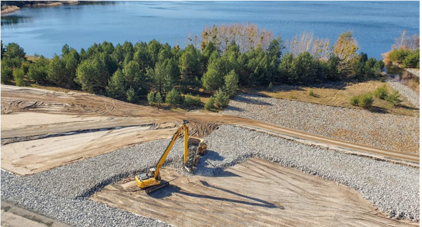
Gestaltung der Südböschung des Sedlitzer Sees im Lausitzer Seenland
