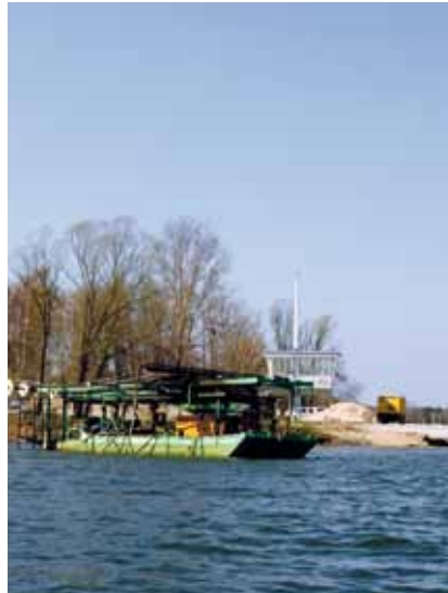
Schwimmpanzer bei der leichten Rüttel-druckverdichtung auf dem Knappensee.
