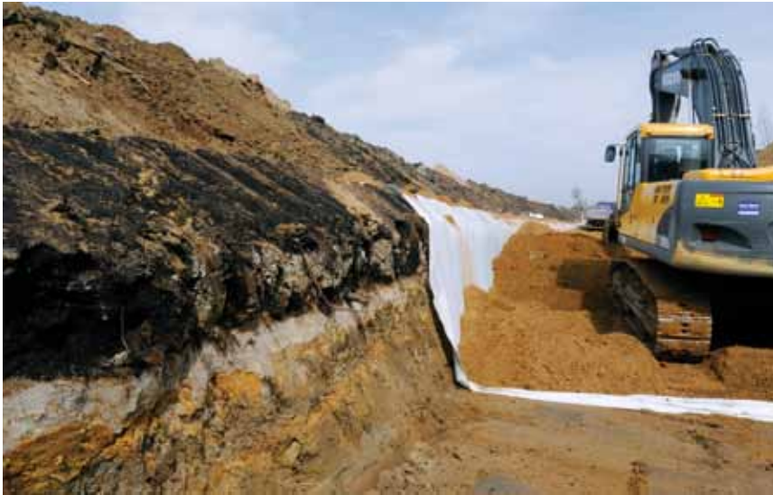
Erdbautechnische Sanierungsarbeiten mit Einbringen von Vlies an den Königsauer Halden.
