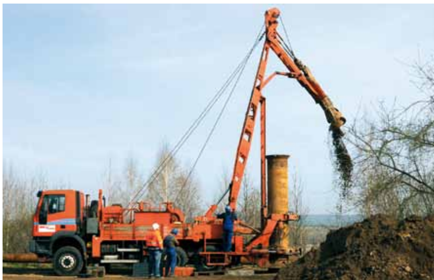
Trockenbohrungen in der Ortslage Nachterstedt zur Erkundung des geologischen Profils.
