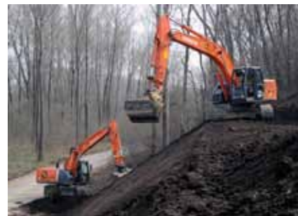
Aufbringen von Mutterboden.
