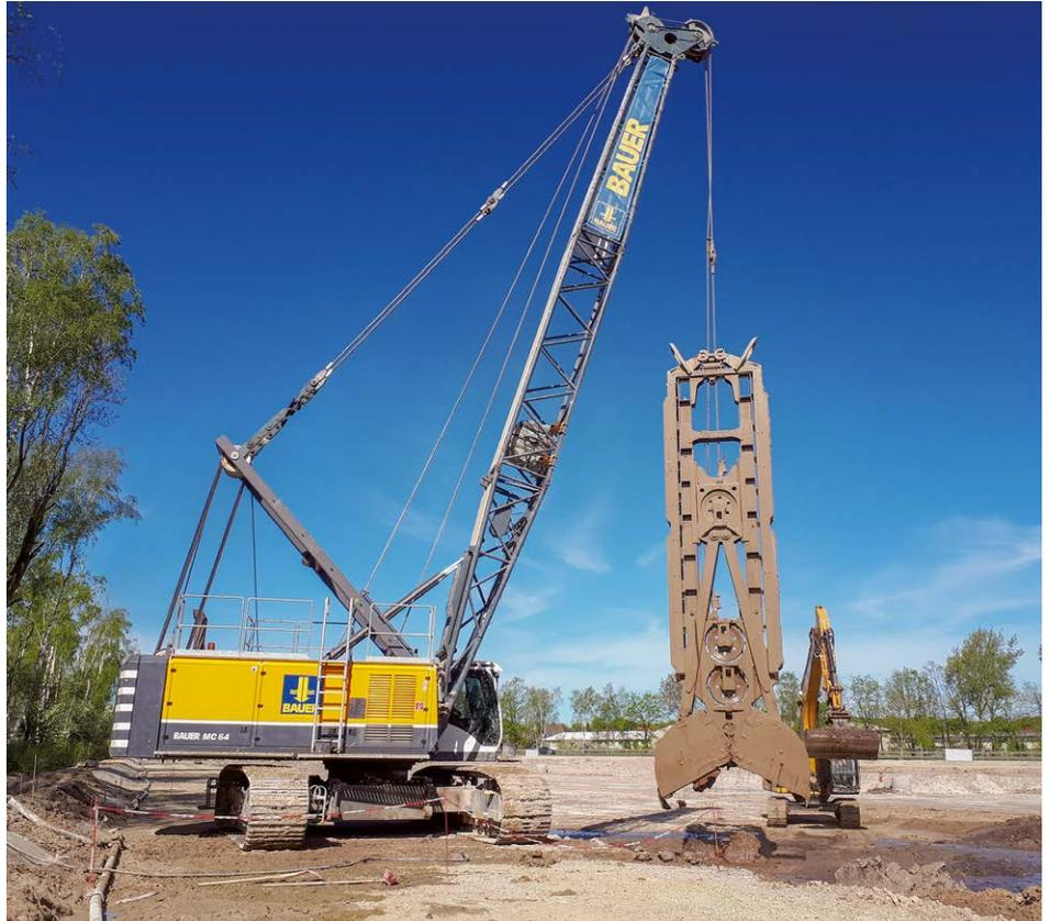
Für den Bau der Dichtwand kommen zwei dieser Seilbagger mit Schlitzwandgreifer zum Einsatz, die die rund 60 Zentimeter breite Wand in den Untergrund einbauen.
