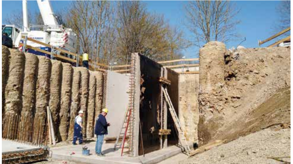
Blick auf den entstehenden Speicherschacht in Friedrichsrode
