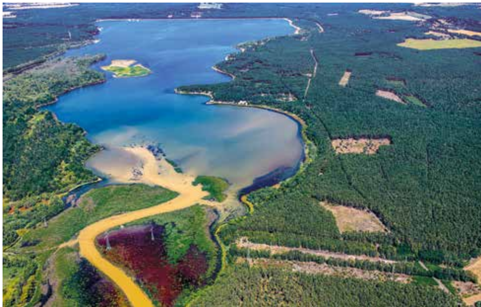
Die Konditionierungsanlage vor der Talsperre Spremberg, hier der Einlauf, dient dem Eisenrückhalt.
