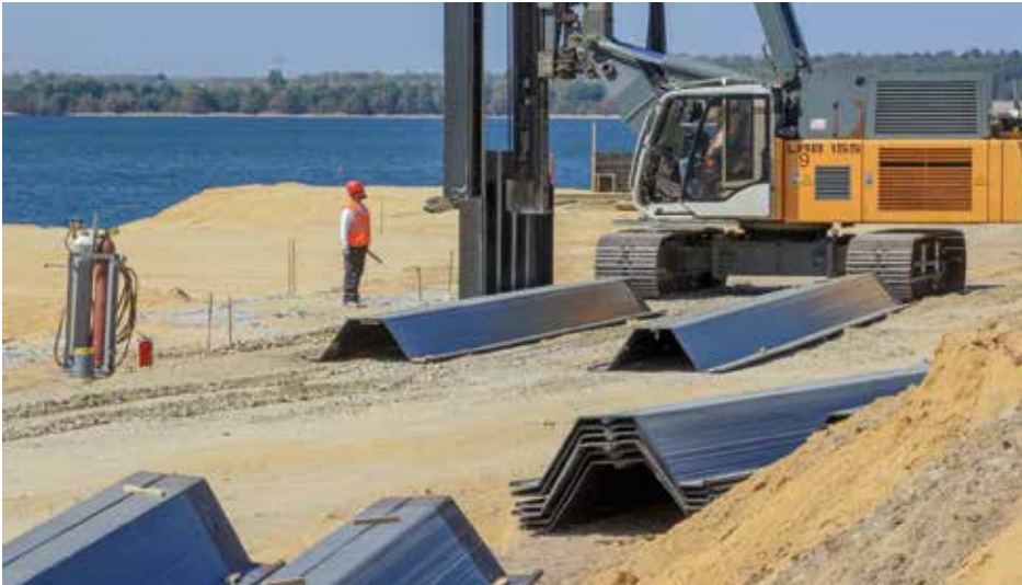
Die Bohlen für die Spundwand am geplanten Sanierungsstützpunkt am Sedlitzer See werden gerammt.
