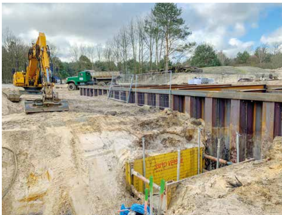
Blick auf die Baustelle der Modulare Wasserbehandlungsanlage Ruhlmühle am Altarm der Spree
