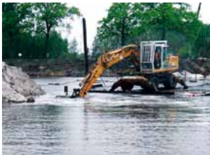
Sanierungsarbeiten im Clubteich.
