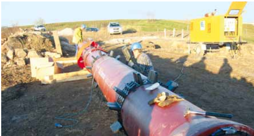
Verlegt wurde die Leitung im Innenkippenbereich des ehemaligen Tagebaus Espenhain.
