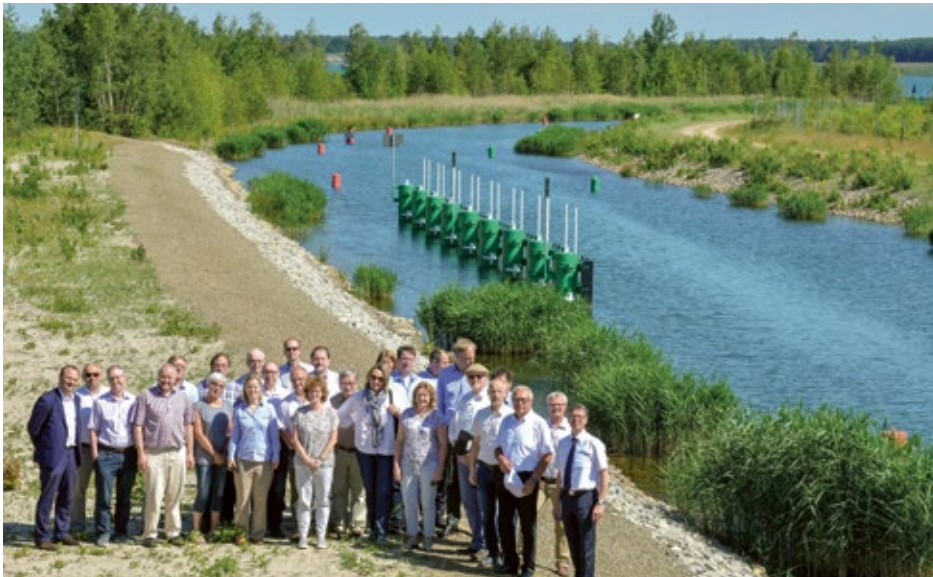
Ein Zwischenstopp am fertiggestellten Barbarakanal war Teil der Revierbefahrung.
