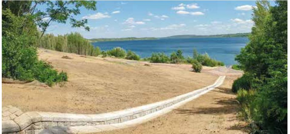
Hinter der neuen Kaskade liegt der 5-stufige Flächenfilter mit einer Gesamtstärke von mindestens 1,30 m.
