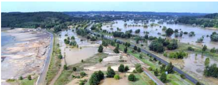
Die Flut beschädigte Böschungen und den Uferweg am Berzdorfer See (links im Bild).
