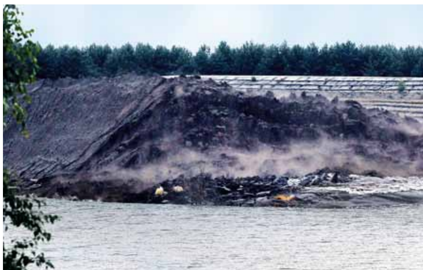
Erfolgreiche Testsprengung an der kippenseitigen Böschung am Sabrodder See.
