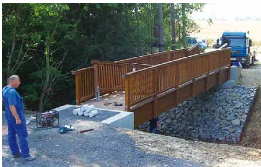
Nach der Anlieferung per Tieflader erfolgte die Montage der hölzernen Brücke.
