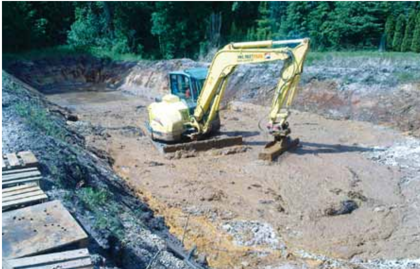
Zur Ertüchtigung der Becken finden u. a. Maßnahmen zur Schlammberäumung statt.
