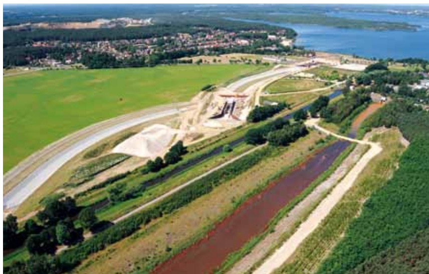
Auf der Großbaustelle des Überleiters 12 zwischen Geierswalder und Senftenberger See lässt sich deutlich das Bauwerk der Schleusenammer mit Vorhafen erkennen.
