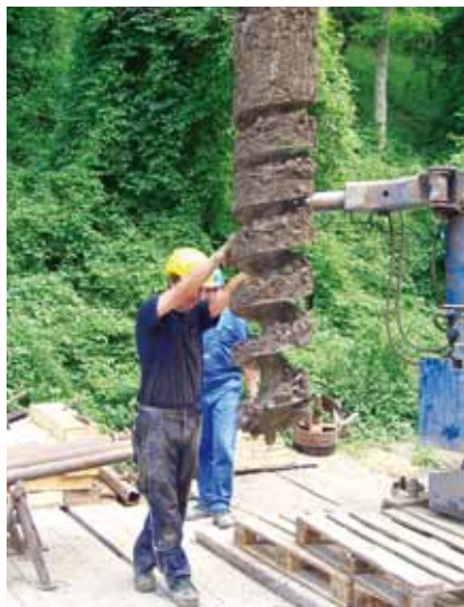
Im Juli fanden in Nachterstedt weitere Bohrungen im Umfeld des Schadensgebiets statt.
