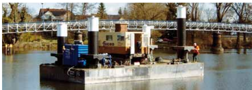
Künftige geotechnische Tiefenbohrungen sollen, vorbehaltlich der LAGB-Genehmigung, mit Hilfe von hochseetauglichen Pontons direkt auf dem Concordia See vorgenommen werden.
