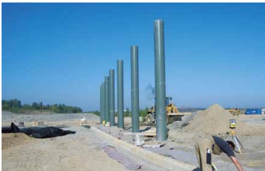
Mehrere Dalben, also Pfähle zum Befestigen von Schiffen, sind bereits eingebaut worden.
