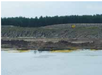
Die fünfte reguläre Sprengung am Sabrodter See verlief planmäßig.
