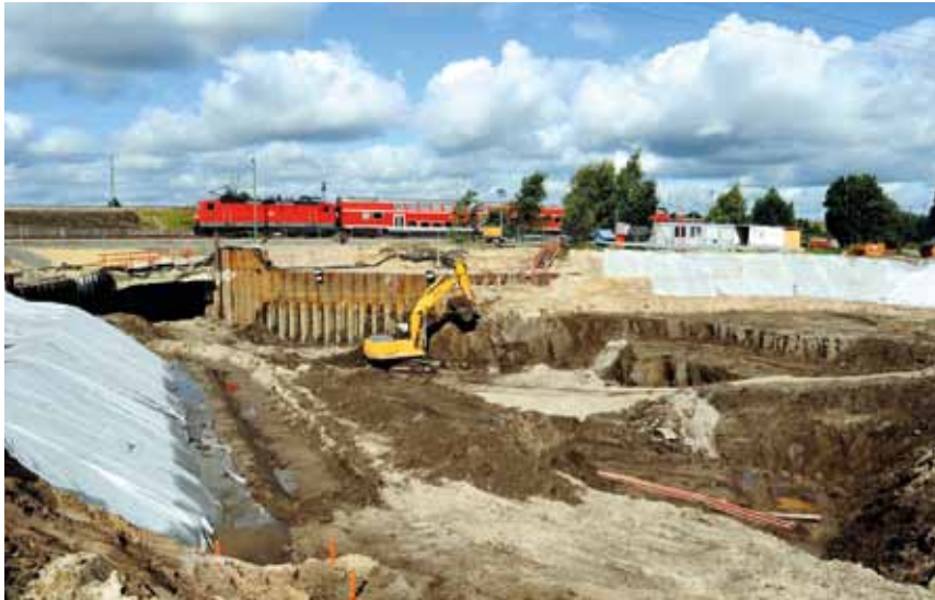
Bahn fährt wieder: Bahntrasse und Tunnelsegment am Überleiter 11 bei Sedlitz.
