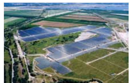
Auf der Innenkippe des ehemaligen Tagebaus Meuro entsteht ein etwa 320 Hektar großer Solarpark. Er soll mit einer Gesamtleistung von etwa 80 Megawatt pro Jahr ans Netz gehen.
