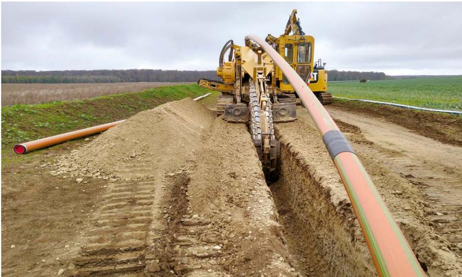
Die Rohrleitungsverlegung erfolgt mittels einer Grabenfräse.
