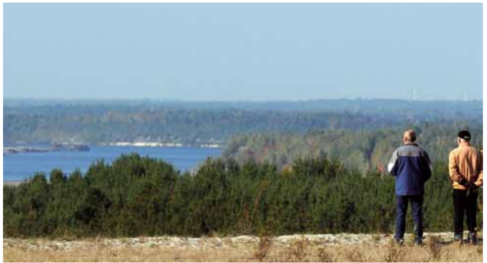
Trotz des Grundbruches im Raum des ehemaligen Tageaufeldes Spreetal ist die Entwicklung im Lausitzer Seenland nicht gefährdet und das Interesse weiterhin groß.
