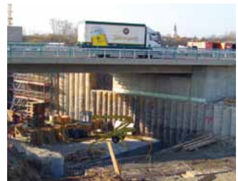
Seit November rollt der Verkehr über die Brücke des künftigen Überleiterbauwerkes bei Zitzschen.
