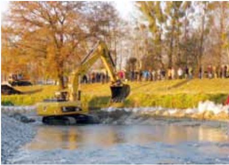
Das Wasser erobert das neue ca. 800 Meter lange Flussbett der Schwarzen Elster.
