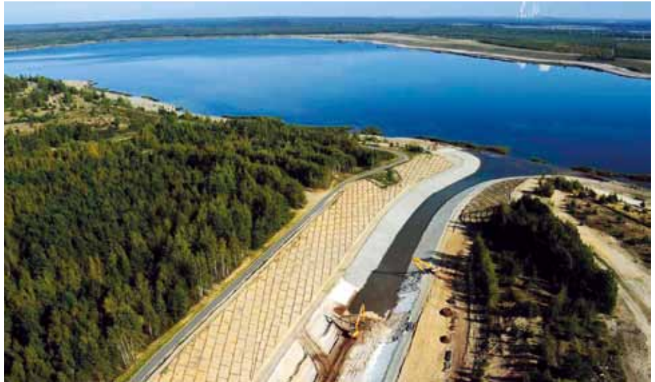
In einigen Teilbereichen ist der Überleiter 1 zwischen Spreetaler und Sabrodter See schon fertig.
