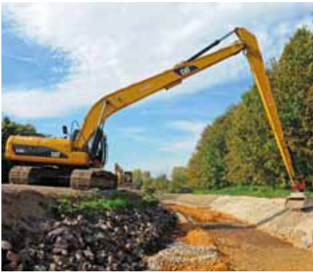
Durch den Ausbau des Lobers und die Entfernung der Kolmationsschicht durch die LMBV kann das Gewässer künftig wieder seine ursprüngliche Funktion als Vorfluter aufnehmen.
