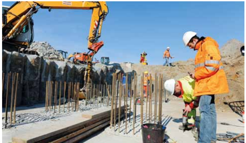
Das Überleiterbauwerk an der Hochwasserentlastungsanlage bei Zitzschen soll Mitte 2012 fertig werden.
