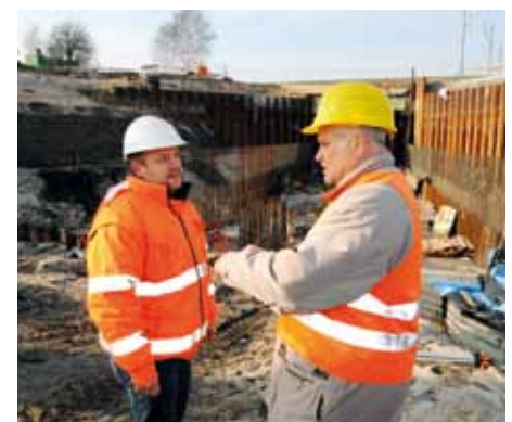
LMBV-Projektmanager Balzer am Überleiter 11.
