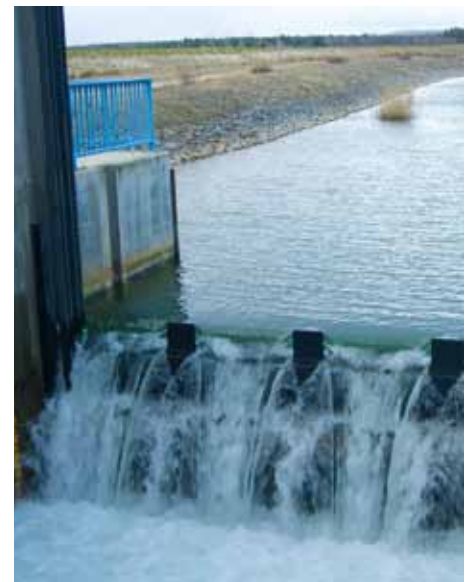
Flutung des Partwitzer Sees über den Barbarakanal.
