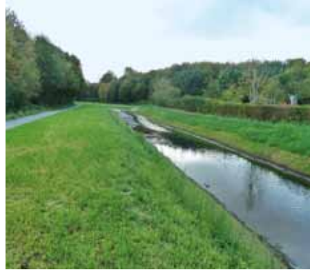
Durch den Ausbau des Lobers und die Entfernung der Kolmationsschicht durch die LMBV kann das Gewässer künftig wieder seine ursprüngliche Funktion als Vorfluter aufnehmen.
