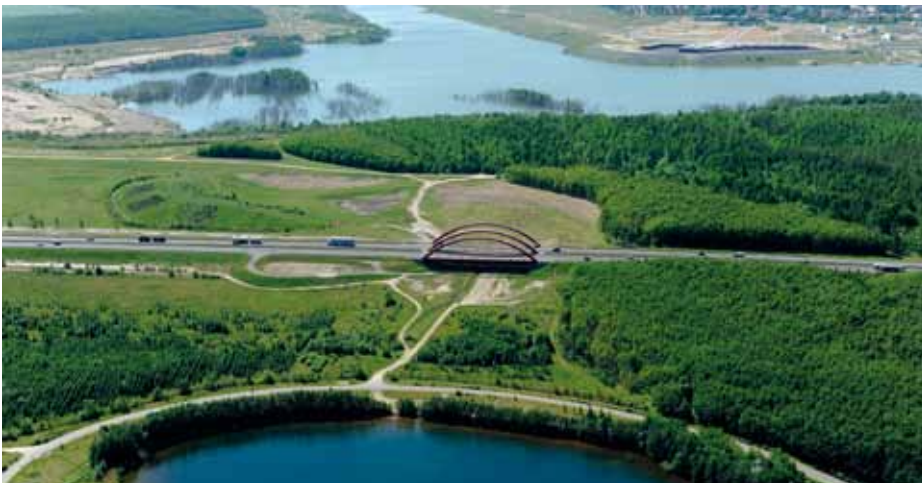
Zwischen den beiden Seen beginnen bald die vorbereitenden Arbeiten für den Kanalbau.
