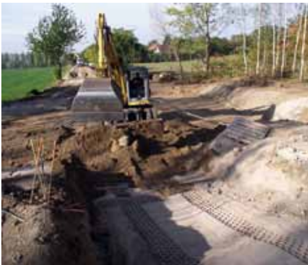
Baggereinsatz bei der Straßensanierung.
