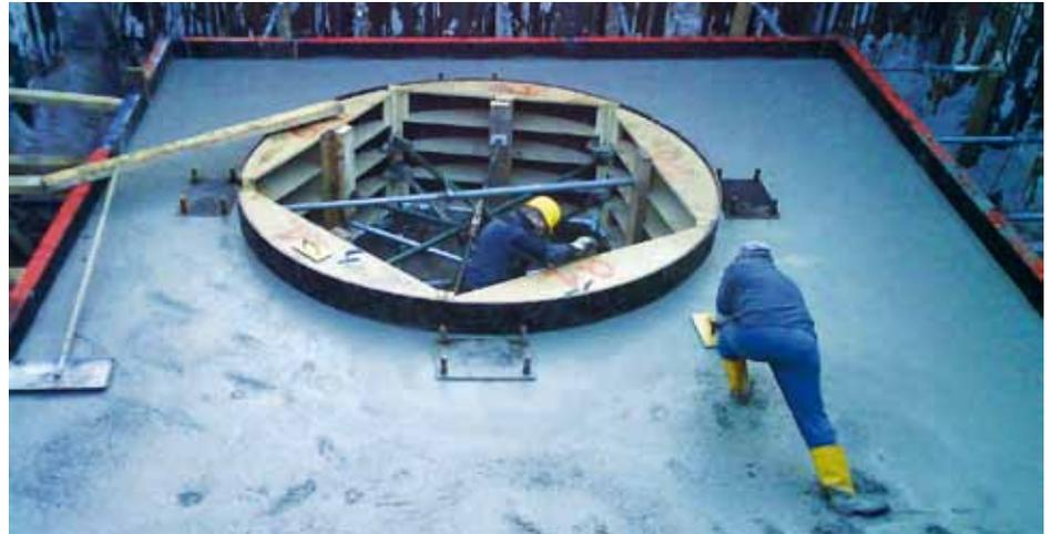
Im Bereich der Güterbahnhofstraße wird der Horizontalfilterbrunnen 6 errichtet.
