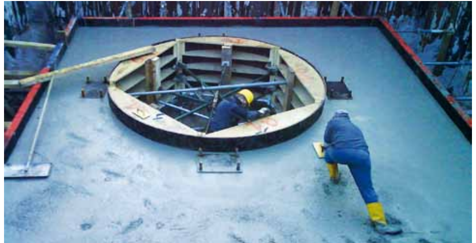
Im Bereich der Güterbahnhofstraße wird der Horizontalfilterbrunnen 6 errichtet.
