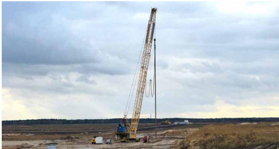
Die LMBV-Verdichtungsarbeiten an der Südböschung des stillgelegten Tagebaus Cottbus-Nord sind vollendet.
