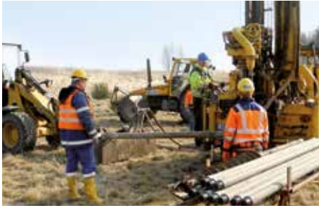
Mitarbeiter der BUG Dienstleistungen GmbH beim Herstellen der Sprengbohrlöcher im Trassenabschnitt 1
