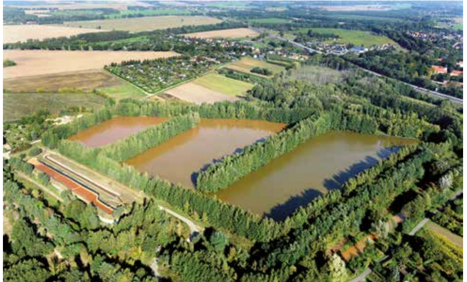
Absetzbecken der Wasserbehandlungsanlage
