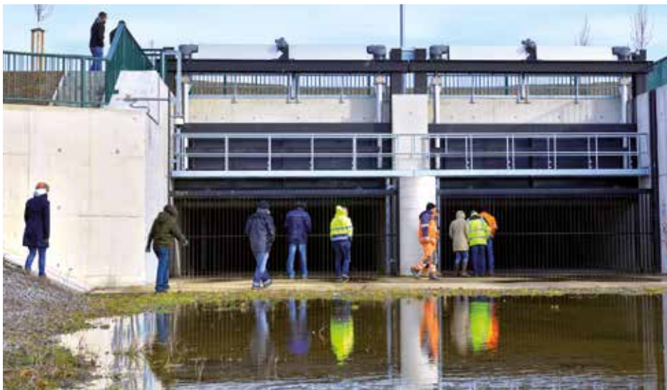
Bereich des Einlaufkanals des Betriebsauslasses auf der Zwenkauer Seeseite
