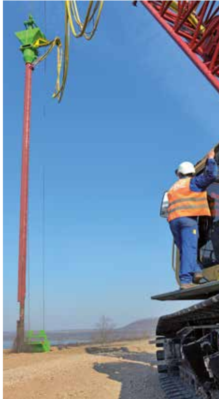
RSV-Gerät im Einsatz am Ufer des Concordiasees
