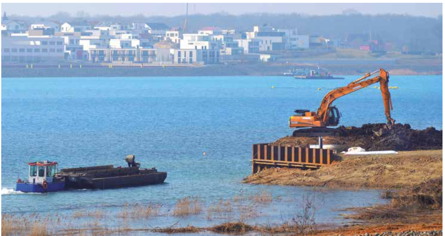
Mithilfe einer Schute werden die bei der Baugrundverbesserung anfallenden Überschussmassen in den Zwenkauer See verklappt.
