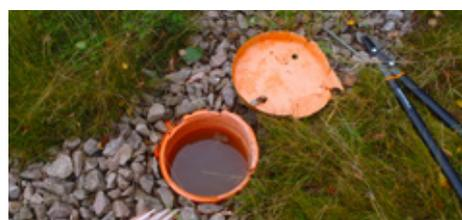
*Zugesetzter Entwässerungs- bzw. Kontrollschacht nach Starkregen*
