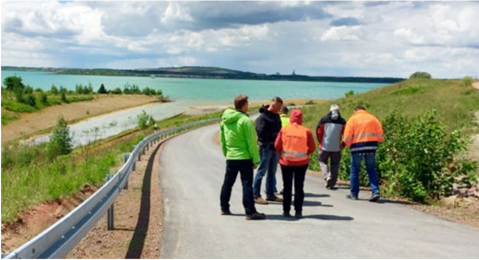
Abnahme des asphaltierten Wirtschaftsweges erfolgt.
