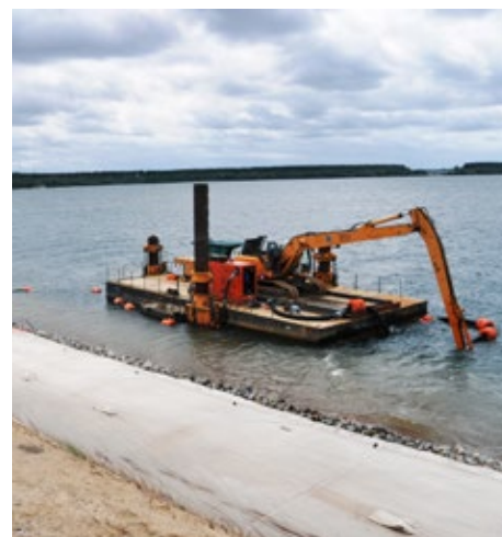
Geotubes erstrecken sich am Ufer des Sedlitzer Sees - Vom Schwimmponton aus werden diese gefüllt.
