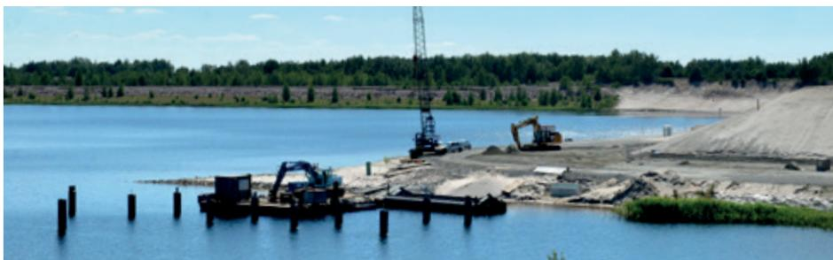
Am Bergheider See setzte ein Kran – auf einem Ponton schwimmend – Dalben in den Seeboden.
