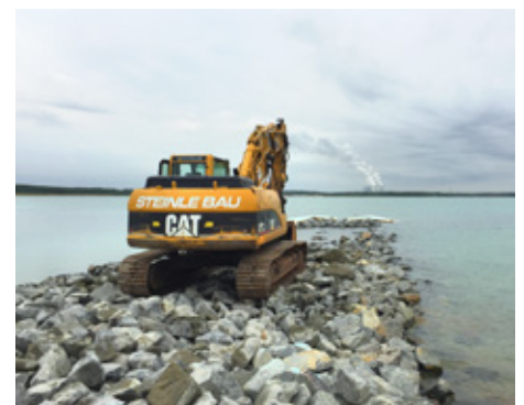
Nachdem Schüttmassen aufgebracht wurden, müssen diese nun zwölf Wochen ruhen.
