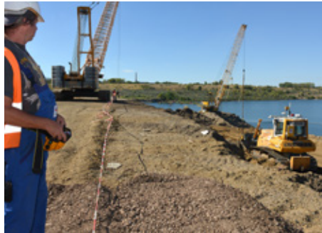
Sicherheit geht vor – Einsatz einer ferngesteuerten Raupe.
