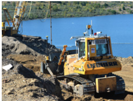
Das Herstellen der Bergerampe kommt voran.
