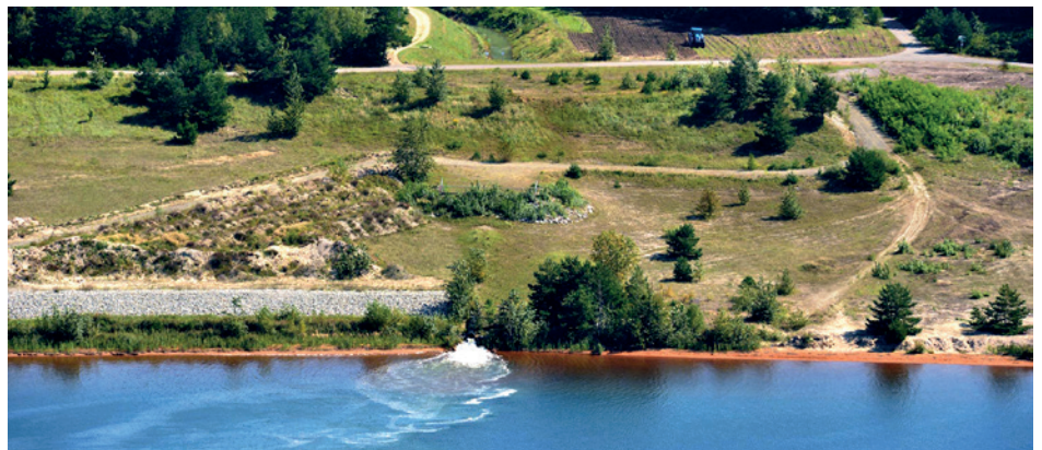
Sedlitzer See – Wasserzuführung aus dem Oberen Landgraben
