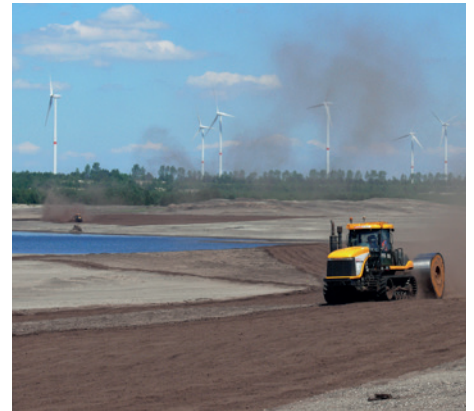
LANDPAC-Walze mit Stahlbandage an der Schwarzen Keute in Aktion
