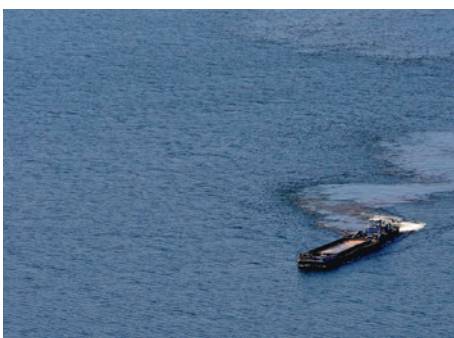
Schuteneinsatz beim Überhöhenabtrag
