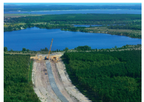
Verdichten der Ableitertrasse
