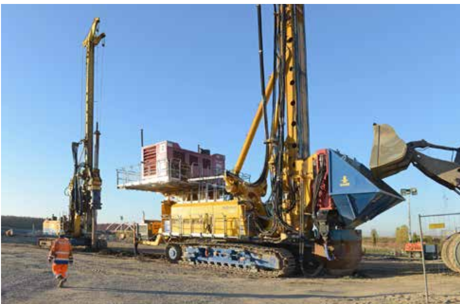
Zwischen dem Zwenkauer See und dem Cospudener See wird mit mehreren Geräten gleichzeitig der Kippen-Baugrund gestopft und verdichtet.
