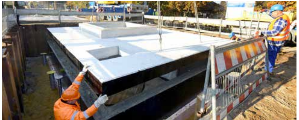
Ein präzise gegossener Deckel für die Pumpenstube wurde am 4. November eingeschwenkt.
