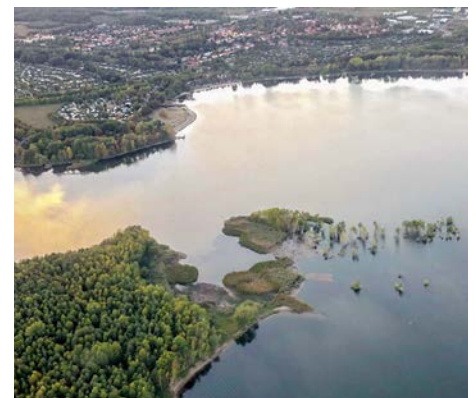
Rutschung am Inselbereich des Senftenberger Sees
