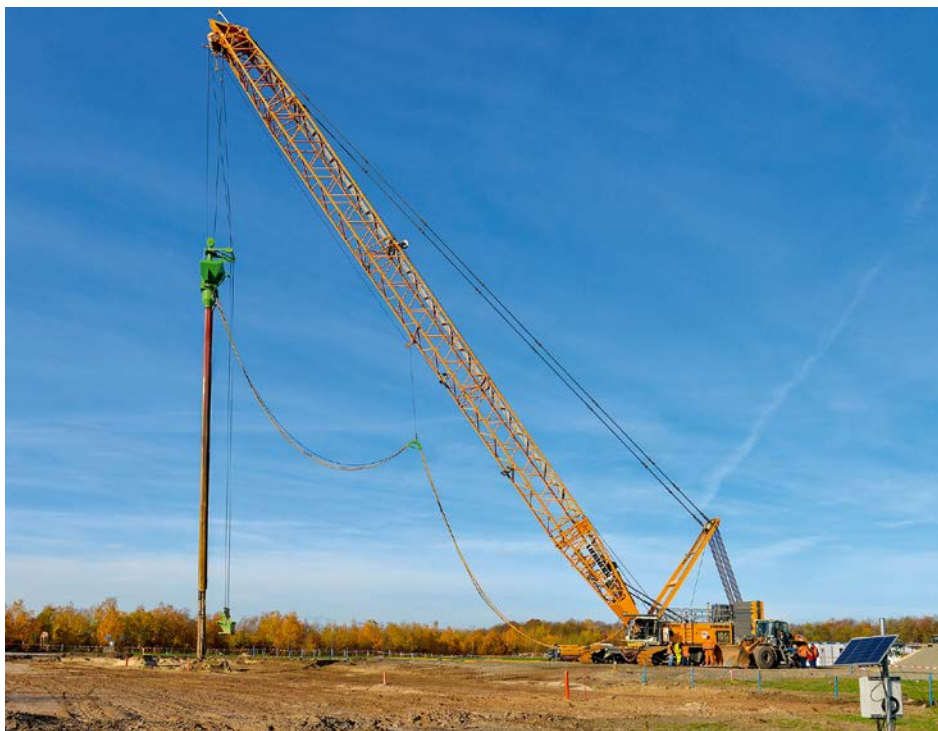
An der Hochkippe Borna wird der Untergrund mittels Rüttelstopfverdichtung stabilisiert.
