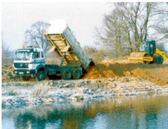
Mit mobiler Technik haben Mitarbeiter der Firma Bau- und Wassertechnik Bad Dübener den zerstörten Sperrdamm am Rande der Stadt wieder instand gesetzt.
