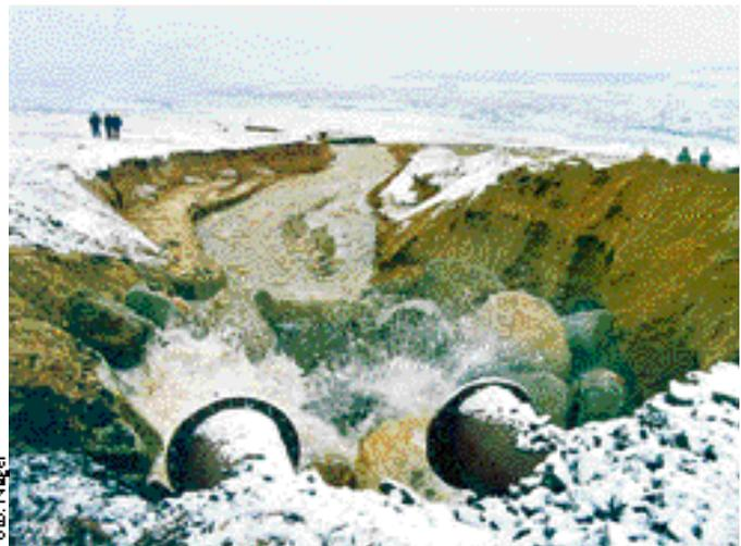
Mit enormer Kraft zerstört das Neißewasser sanierte Böschungen.
