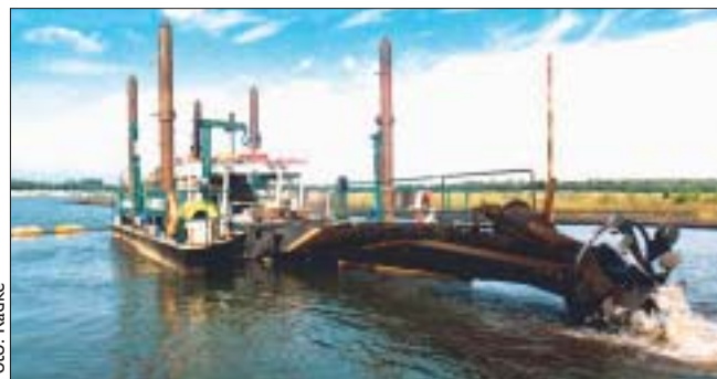
Ein Saugbagger wälzt die im See abgelagerte Kraftwerksasche um.
