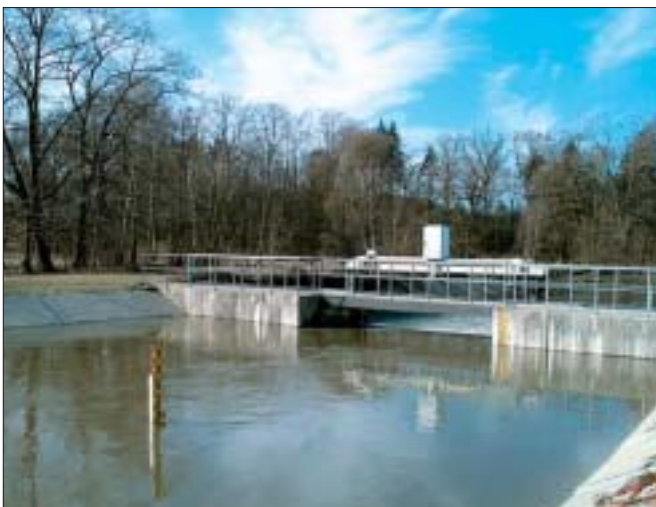
Hier am Bärwalder Wehr beginnt der 2800 Meter lange Zuleiter von der Spree zum Wasserspeicher Lohsa II. Seinen ersten Härte-test bestanden Wehr, Kanal und Sturzrinne mit dem Januar-Hochwasser.
