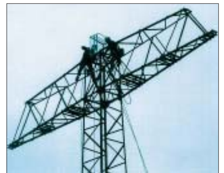
Freileitungsmonteur der Meag richten in luftiger Höhe Kunsthorste für Fischadler ein.
