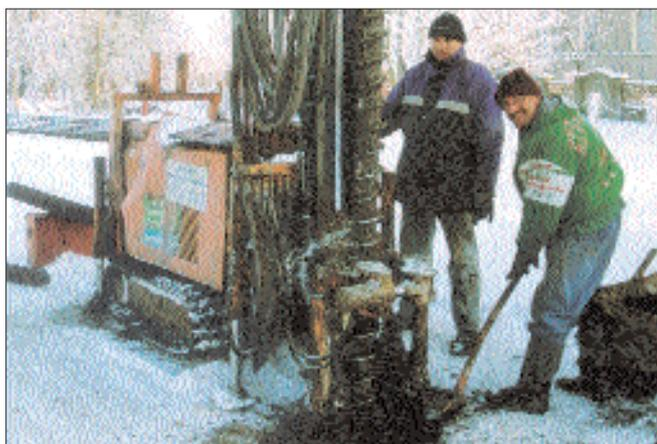
**Holzweißig.** Seit Januar führen Mitarbeiter der Firma Landsberger Bohr- und Brunnenbau GmbH im Auftrag der LMBV Versatzarbeiten zur Sicherung untertägiger bergmännischer Auffahrungen durch. Durch diese Sanierungsmaßnahme wird die öffentliche Sicherheit hergestellt.
