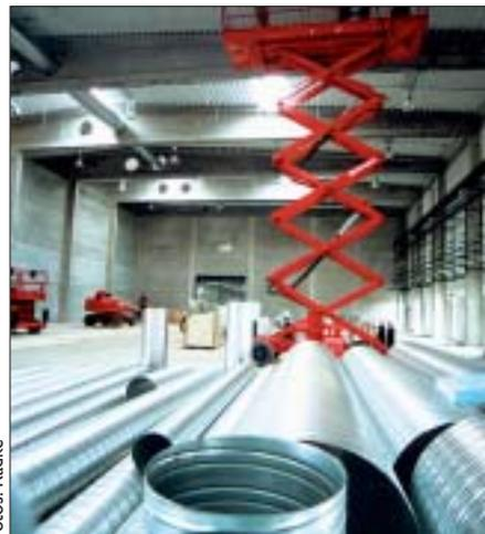
Endspurt bei Vestas: Montage der Heizungs- und Lüftungsrohre in der Produktionshalle.
