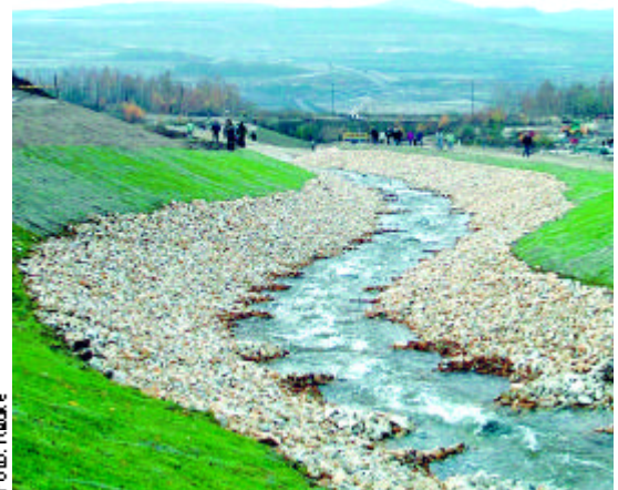
Schnelle Entscheidungen sind nötig. Durch diesen Einlaufkanal aus der Pleiße fließt der See täglich mehr.
