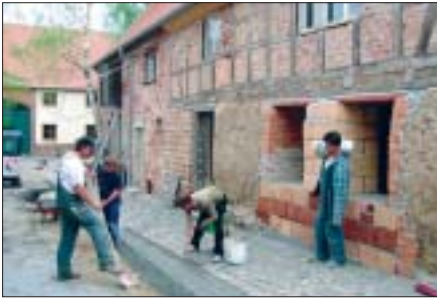
Das halbe Dorf gleicht noch einer Baustelle.
