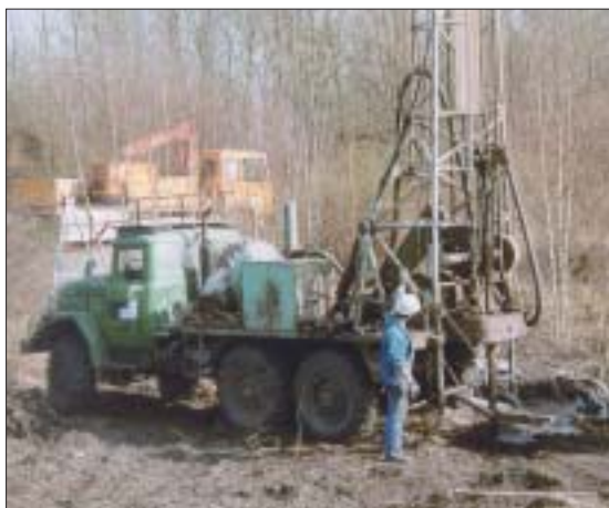
Das Bohrgerät gräbt sich bis zu 33 Meter in die Tiefe.
