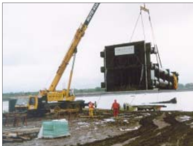
Mittels schwerer Technik bringen Mitarbeiter des Auftragnehmers die Tiefenwasserbelüftungsanlage in den Runstädter See.
