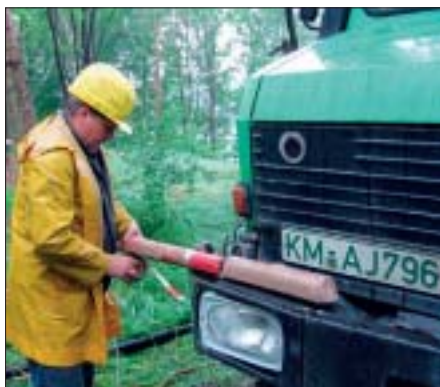
Die Sprengladung wird exakt vorbereitet.
