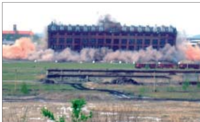
Exakt wie geplant und vorberechnet kam die 34 Meter hohe Brikettfabrik Espenhain I zu Fall.
