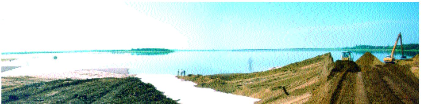
Bereits fertiggestellter Bereich des Pilotobjektes (links). Einbau einer Flächendränage (Mitte). Die aufzuschüttenden Erdmassen (rechts).
