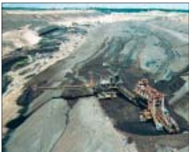
Erdarbeiten mit Großgeräten im Bereich des künftigen Ilse-Sees
