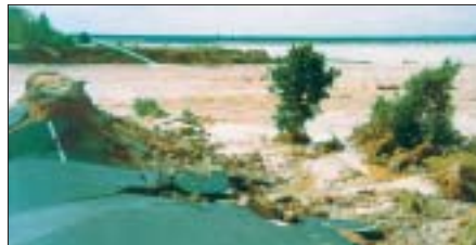
Die Fluten der Mulde zerstören Böschungen und spülen selbst Straßen hinweg.
