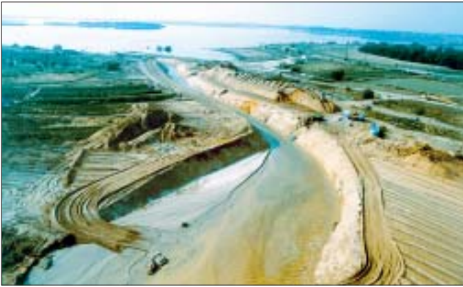
Im Auftrag der LMBV wird ein 400 Meter langer und bis zu etwa acht Meter tiefer Graben gebaut, um das Wasser der stark überfluteten Goitzsche in das benachbarte Tagebaurestloch Rösa abzuleiten.
