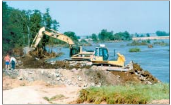
Der Katastrophenstab der Stadt Bitterfeld ordnet an, einen Schutzdamm zum Abriegeln des in die Goitzsche fließenden Muldehochwassers mit schwerer Technik zu errichten.
