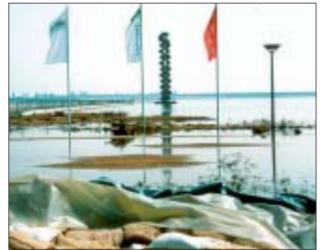
Die Lage der Seebrücke und des Pegelturmes ist an mehreren Tagen bedrohlich ernst.
