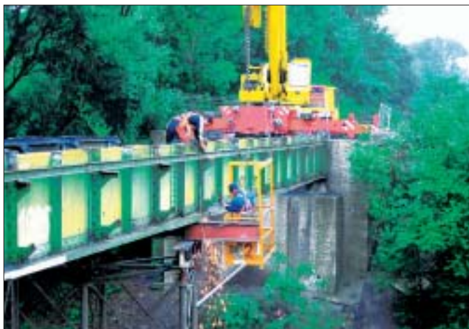
Rückbau der ehemaligen Kohleverbindungsbahnbrücke bei Böhlen
