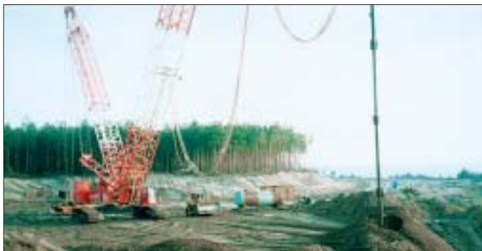
Die Lausitzer Seenkette wächst: Rütteldruckverdichten am Ufer des einstigen Tagebaues Skado Foto: Skorna
