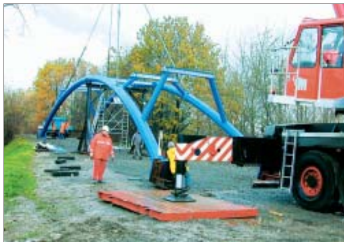
Einbau der neuen Brückenkonstruktionen mit schwerer Technik
