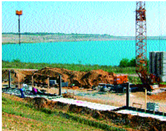
Am Ufer des Markkleeberger Sees errichten Mitarbeiter der Strabag eine Winkelstützwand.
