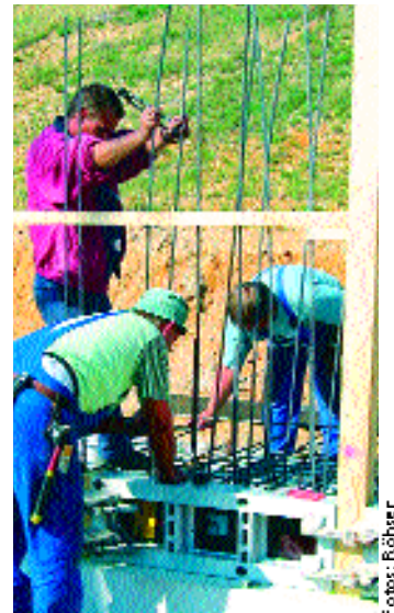
Am Ufer des Markkleeberger Sees errichten Mitarbeiter der Strabag eine Winkelstützwand.
