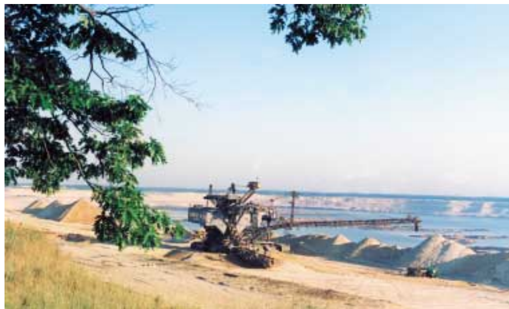
Böschungsgestaltung im ehemaligen Tagebau Scheibe
