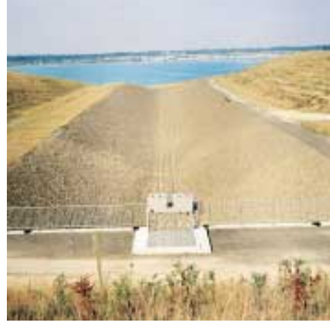
Wasserüberlauf im Speichersystem Lohsa II
