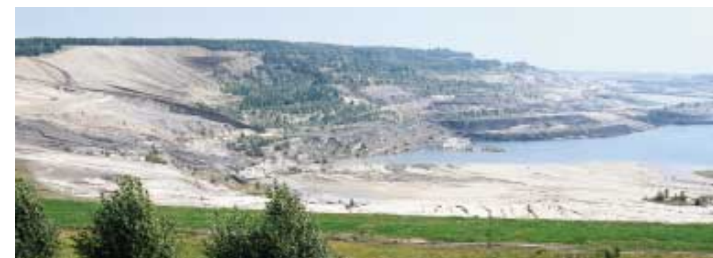
Böschungsabflachung im Tagebaurestloch Mücheln
