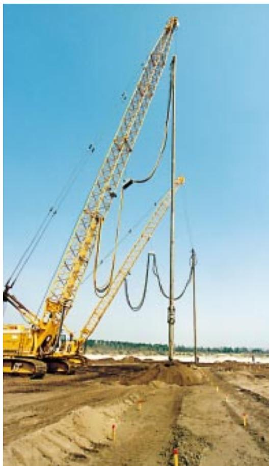
Verdichtung der Trasse eines Zulaufgrabens auf Kippengelände
