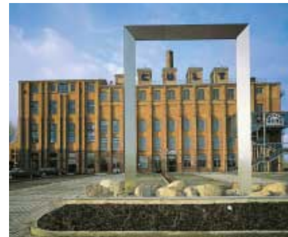
Gelungene Nachnutzung der Brikettfabrik Neukirchen/Wyhra
