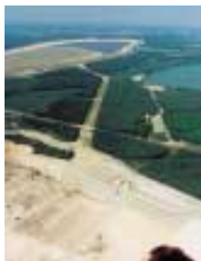
Überleiter zwischen den Tagebauen Burghammer und Lohsa II
