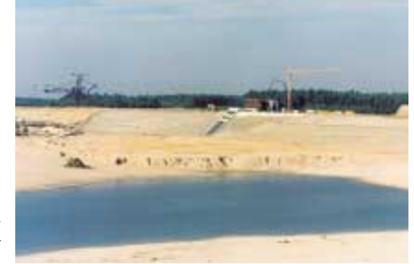
Flutungsbauwerk des Speichersystems Lohsa II
