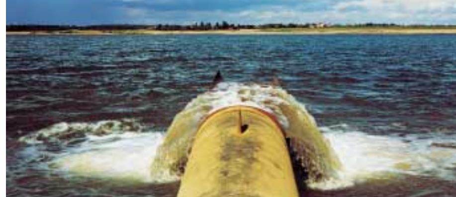
Wassereinleitung in den Tagebau Cospuden
