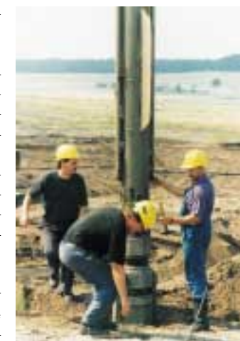
Rütteldruckverdichtung am Koschendam
