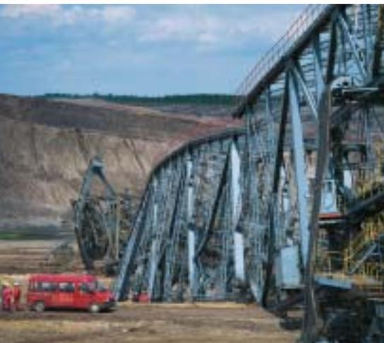
Nach der Sprengung beginnt die arbeitsintensive Demontage der Brücke.
