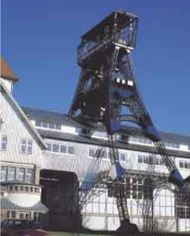
Sondershausen, Hauptsitz der GVV
