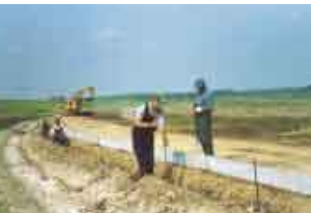
Arbeiten im Tagebau Golpa-Nord
