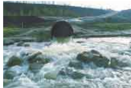
Flutung des Tagebaus Berzdorf aus der Pleißenitz
