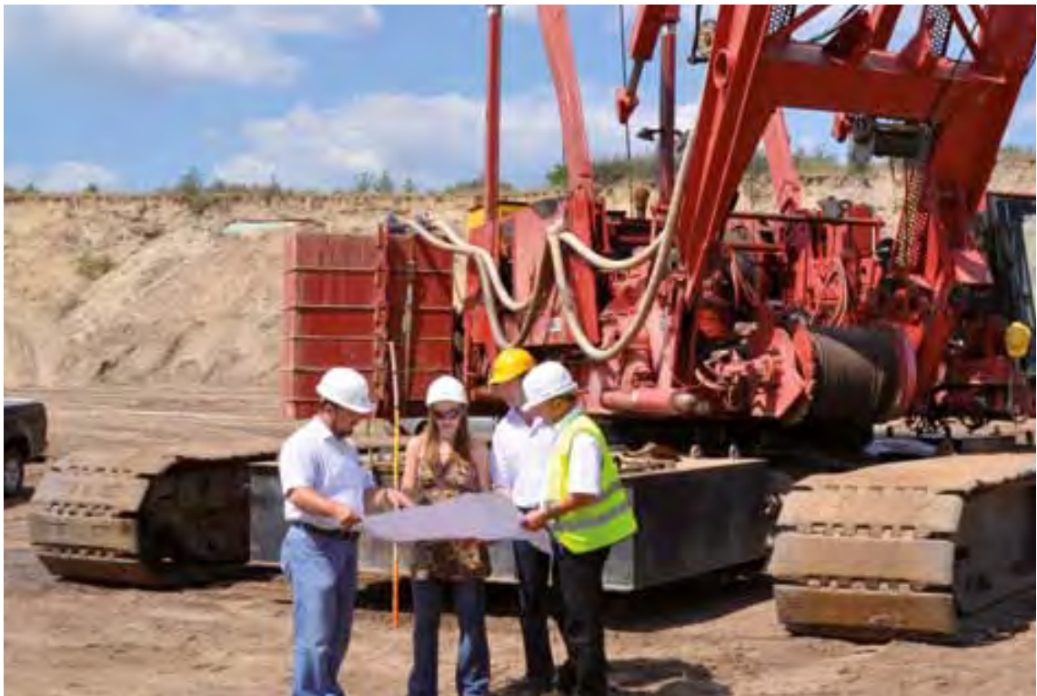
Deutschland: Besichtigung von Sanierungsmaßnahmen der LMBV im ehemaligen Tagebau Greifenhain mit Dr. Anna Ostrega, wissenschaftliche Angestellte der Bergakademie (AGH) Krakau, die bei der LI zu Gast war.
