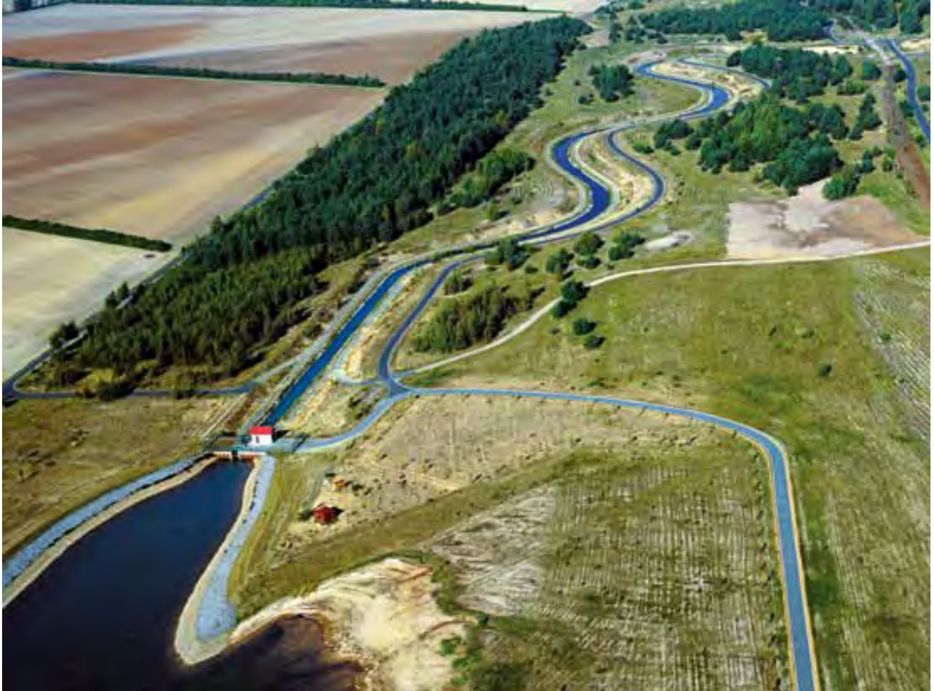
Auslaufbauwerk Bärwalder See
