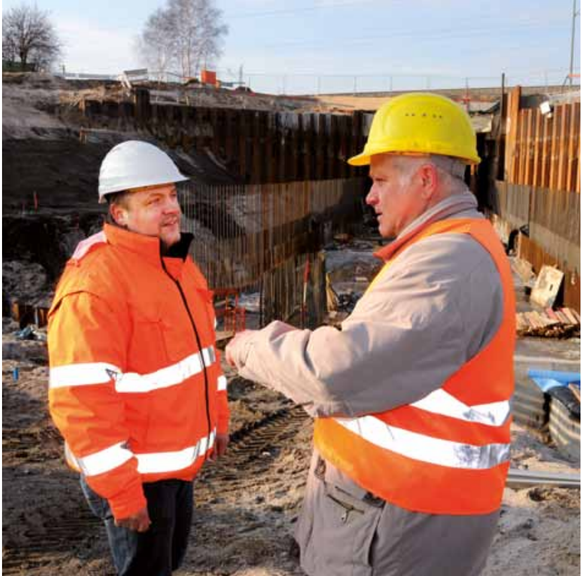
Kontrolle zur Gewährleistung der Arbeitssicherheit am Überleiter 11
