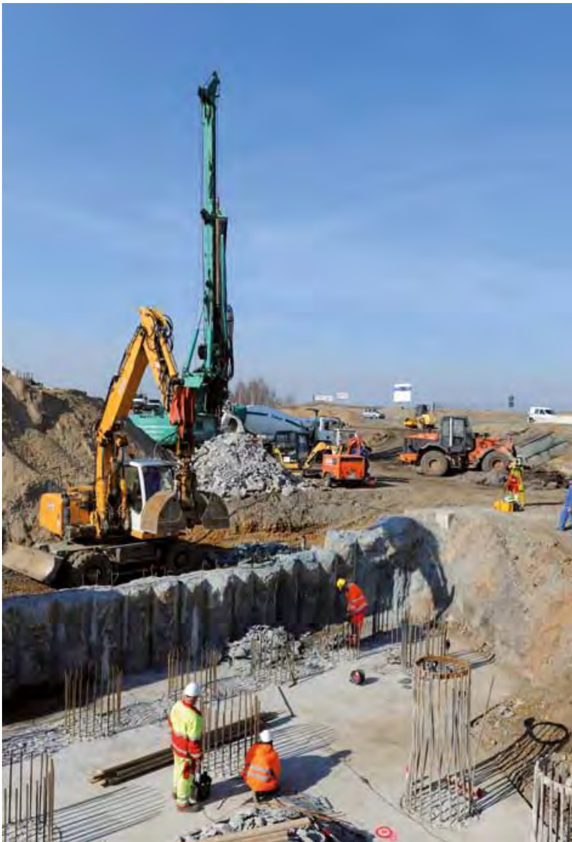
Bau einer Brücke an der B 186 bei Zwenkau für den Überleiter zur Weißen Elster
