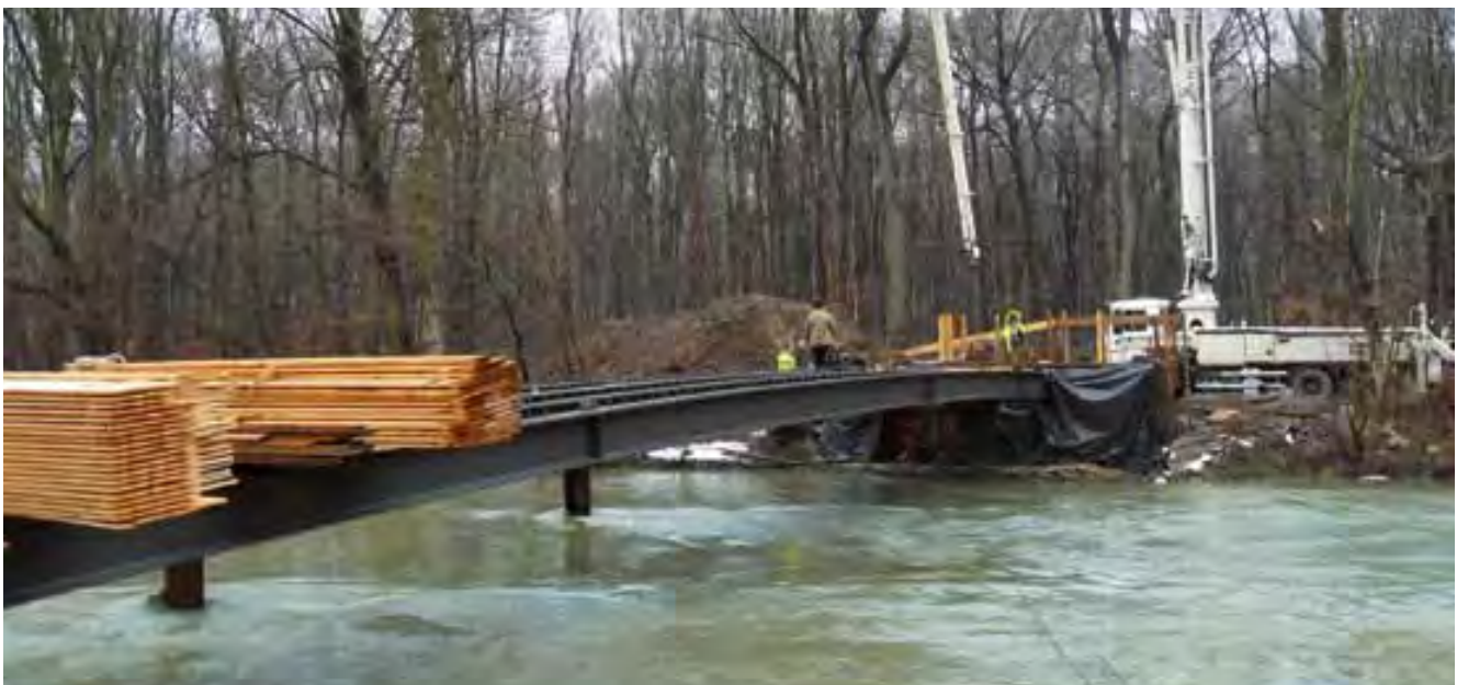
Ersatzneubau der Brücke Probsteisteg
