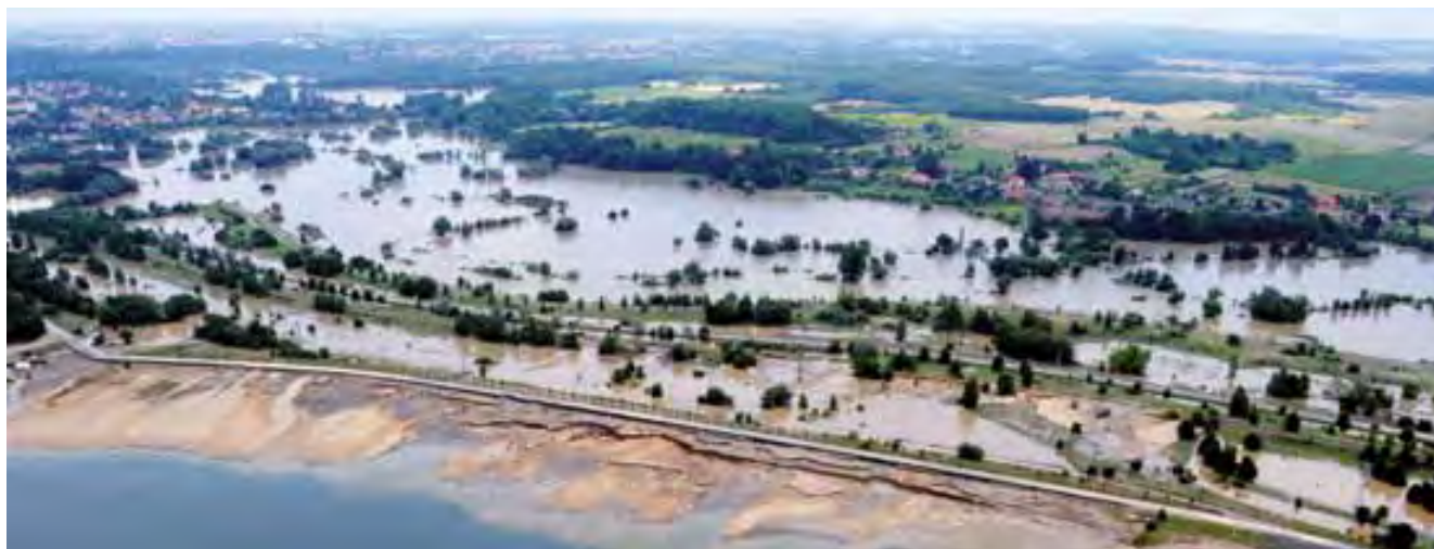
Unkontrollierter Übertritt der Neiße in den Bergbaufogesee Berzdorf, August 2010
