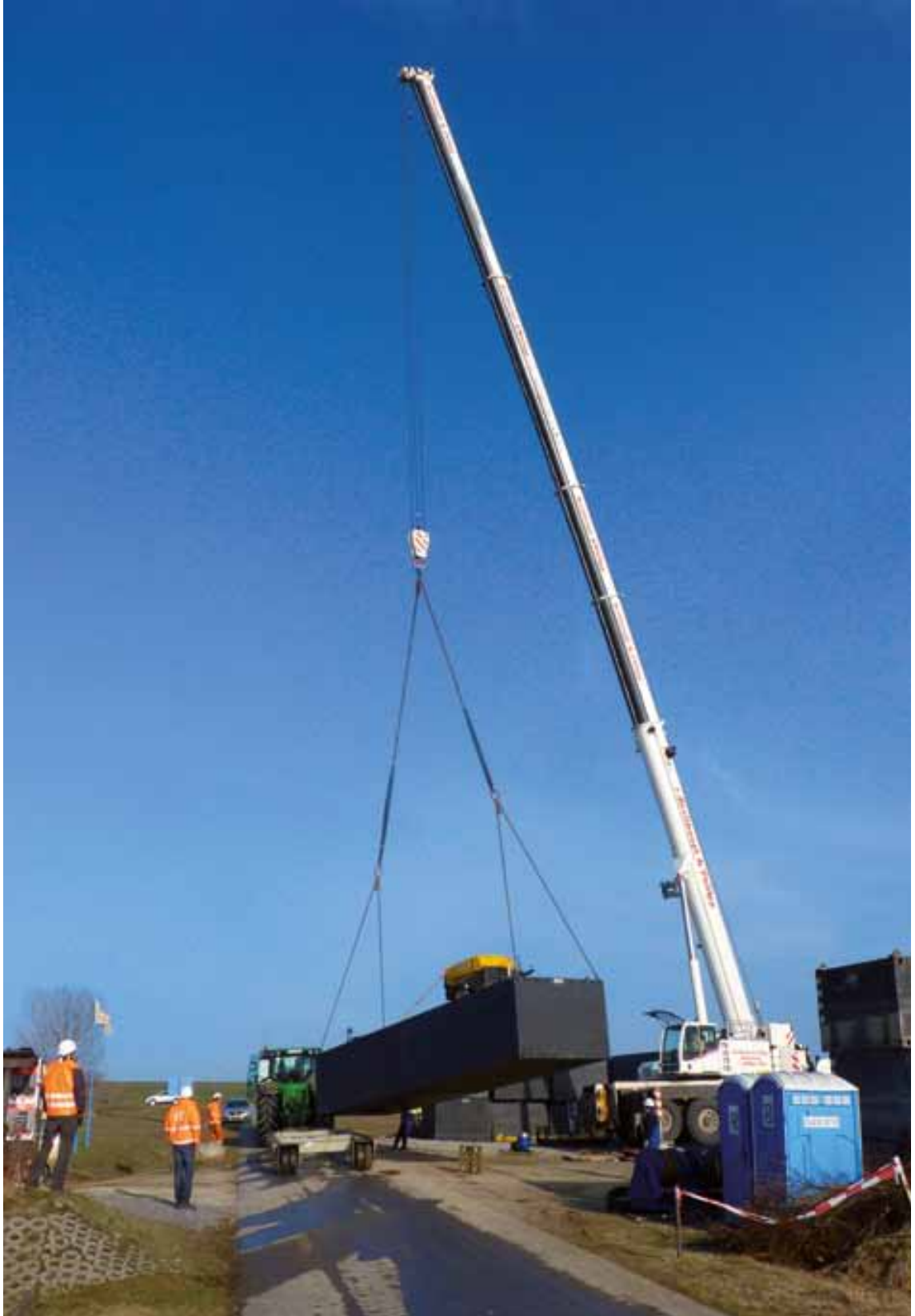
Anlieferung der Pontons im Zwischenlager am Concordia See
