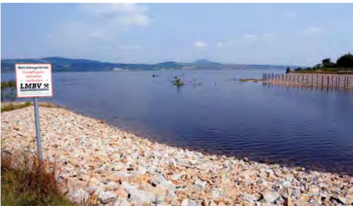
Wasseraufgang im künftigen Hafen des Berzdorfer Sees
