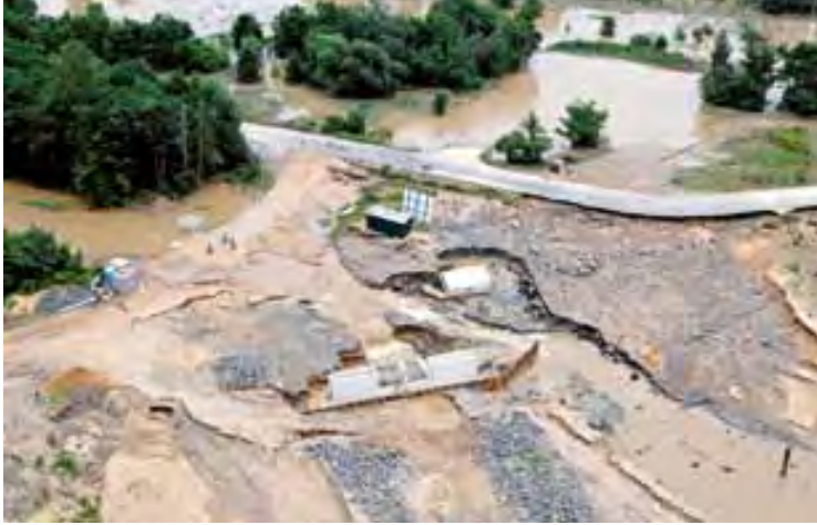
Zerstörtes Auslaufbauwerk Restloch Berzdorf, 8. August 2010
