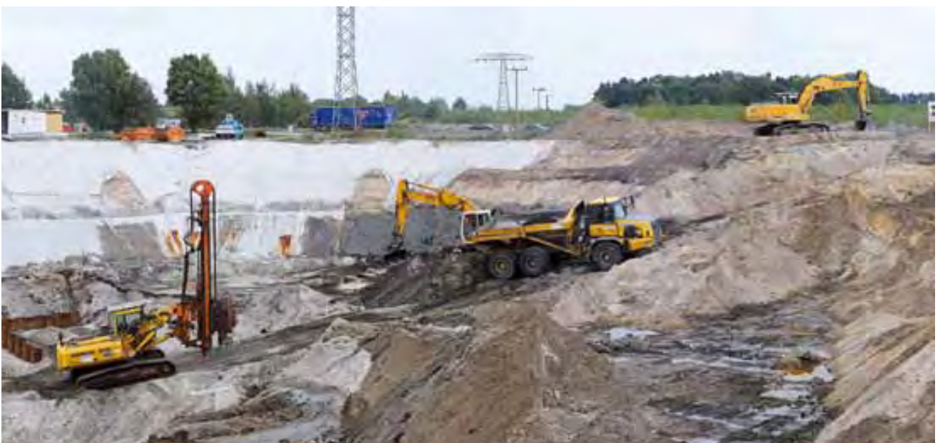
Erdarbeiten am künftigen Überleiter 11 zwischen dem Sedlitz und dem Ilse-See
