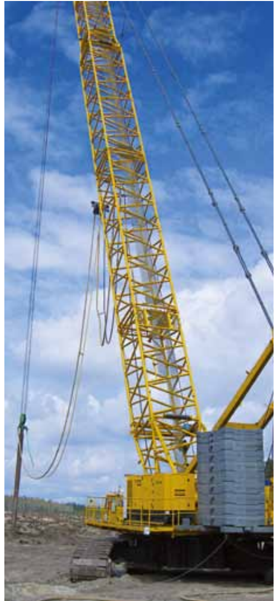
Rütteldruckverdichtung in der Lausitz
