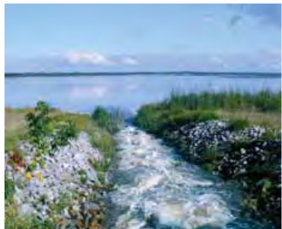
Einlaufbauwerk Schwarze Elster – Neuwieser See
