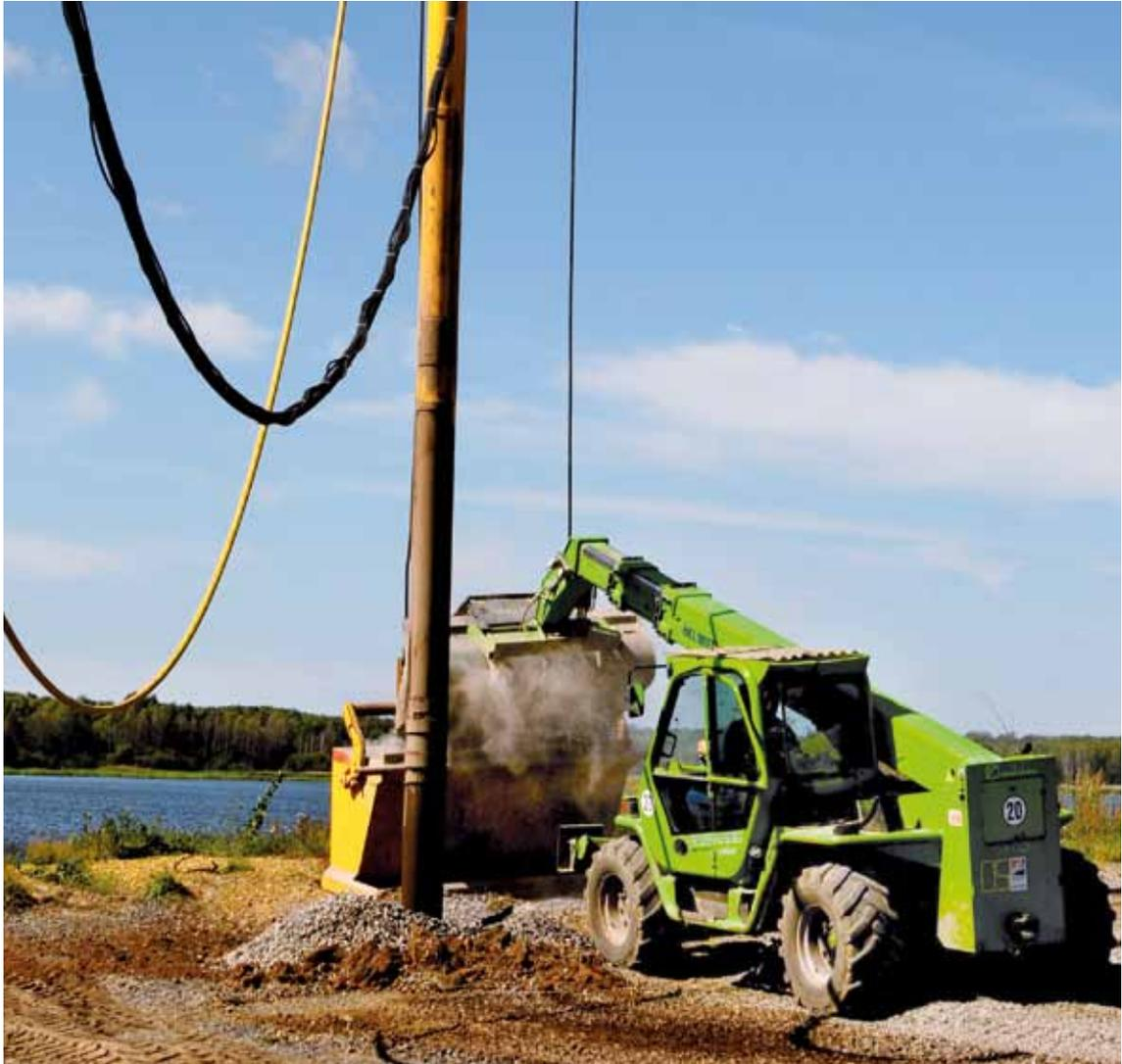
*Silbersee – Rüttelstopfverdichtung mit zugeführtem Material*
