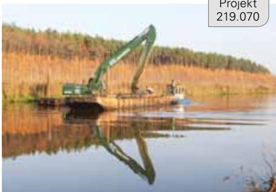
Seit Mitte November wird in der ehemaligen Kohlebahnausfahrt des Tagebaus Koschen mittels Schwimmbagger die Fahrrinne vertieft. Die ausgebaggerten Erdmassen werden per Schubeinheit in das Restloch Koschen abtransportiert und verbracht. Bei der Maßnahme handelt es sich um eine gesplittete Finanzierung zwischen dem § 2 und dem § 4.
