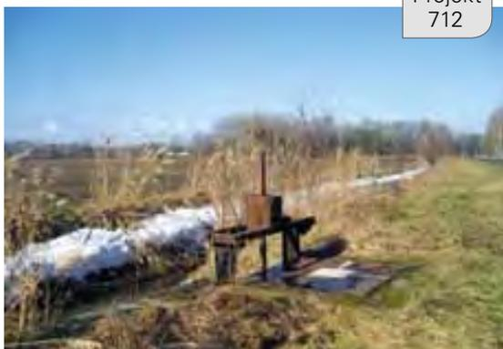
Im Ortsteil Driewitz der Gemeinde Lohsa wurde ein weiterer Abschnitt zur Regulierung der Vorflut fertiggestellt. Auf einer Länge von 1.250 m wurde der „Mittlere Graben“ ausgebaut. Im Rahmen der Maßnahme mussten sechs Durchlässe instand gesetzt werden. Der „Südliche Graben“ ist auf einer Länge von ca. 800 m neu gestaltet worden. Gleichzeitig wurden an diesem Graben vier Durchlässe erneuert.
