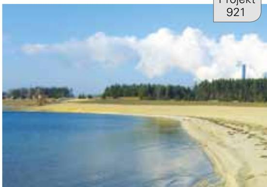
An der Ostböschung des Speicherbeckens Bärwalde sind auf einer Länge von 300 Metern Kliffbildungen durch den Einbau von Wasserbausteinen vollständig beseitigt worden. Im Bereich der Nordböschung wurden auf einer Länge von 80 Metern Erosionsrinnen geschlossen und eine Buhne aus Wasserbausteinen zum Schutz der Böschung fertig gestellt.
