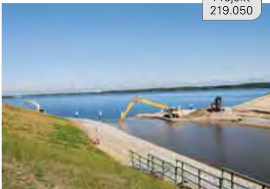
Am Überleiter 12 erfolgten in 2012 der Kanaldurchstich zum Senftenberger See sowie die Böschungsgestaltung. Der Bau des Schleusenbauwerkes ist fortgesetzt worden und aus bautechnischer Sicht abgeschlossen.
