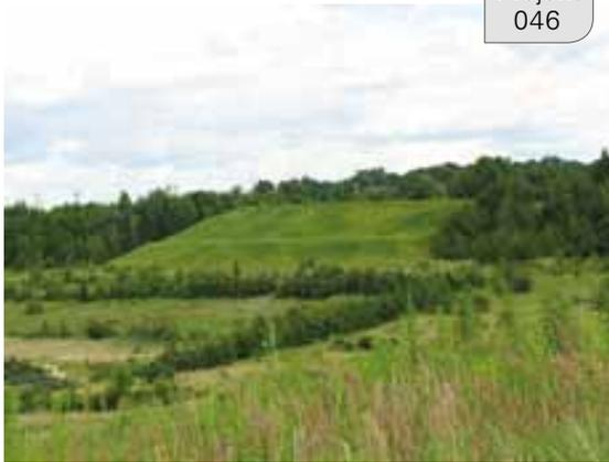
Im April 2012 wurde die Sicherung der Steinekippe Gestewitz im Tagebau Witznitz gegen fortschreitende Erosion abgeschlossen. Durch eine Materialanstützung und den Auftrag von kulturfähigem Boden mit anschließender Begrünung wurde die Böschung gegen weitere Abspülungen/Auswaschungen geschützt.
