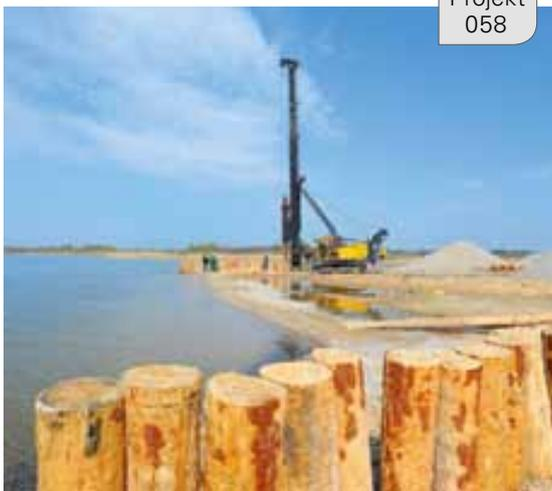
Die wasserbaulichen Arbeiten zur Ufersicherung an der Nordböschung Rösa im sächsischen Teil des Tagebaues Goitsche wurden Anfang Mai 2012 abgeschlossen. Dabei wurde die durch Kliffausbildung in Zusammenhang mit der Windwellenbelastung destabilisierte Böschung gesichert. Nachlaufend erfolgte die Fertigstellungs- und Entwicklungspflege der begrüneten und bepflanzten Flächen.
