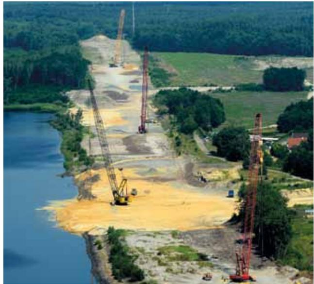
Im Bereich der Innenkippe Lohsa I/Ostböschung Silbersee wurde die Tiefenverdichtung zur Böschungssicherung abgeschlossen. Die mit einem zeitweisen Einsatz von vier Geräten gesicherte Trasse hat eine Länge von ca. 950 Meter, eine Breite von 50 Meter und eine durchschnittliche Tiefe von 32 Meter. Im September 2013 erfolgte die Bekanntmachung des Sächsischen Oberbergamtes über die Durchführung von Maßnah-
