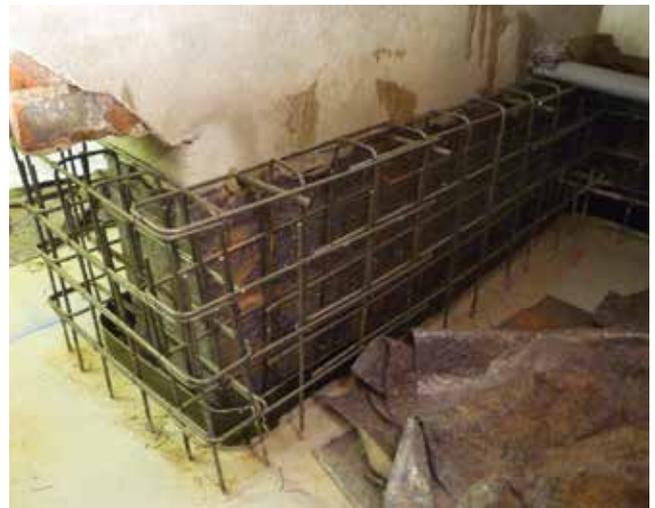
Am Objekt „An der Elster“ in Schkopau im Ortsteil Lochau wurde durch den Einbau einer Weißen Wanne die bautechnische Sicherung beendet.
