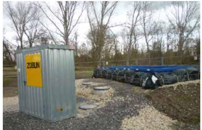
Am Standort Schwelerei Deuben erfolgte die Errichtung von drei zusätzlichen Grundwassermessstellen zur Überwachung der aktiven Grundwassersanierung.
