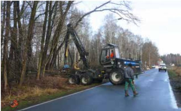
Am Kuthteich in Lauchhammer, dem Restloch 38, wurden in 2016 die vorbereitenden Arbeiten für die anstehende Rüttel-druckverdichtung zur Sicherung der Ostböschung durchgeführt. In einem ersten Bauabschnitt erfolgten die Baufeldberäumung und Holzungsarbeiten sowie die Aktivierung der zukünftigen Baustelleneinrichtungsfläche. Parallel dazu wurde eine Trinkwasserleitung, DN 1000, aus dem Baubereich umverlegt. Die notwendige Rütteltechnik wurde bereits montiert.
