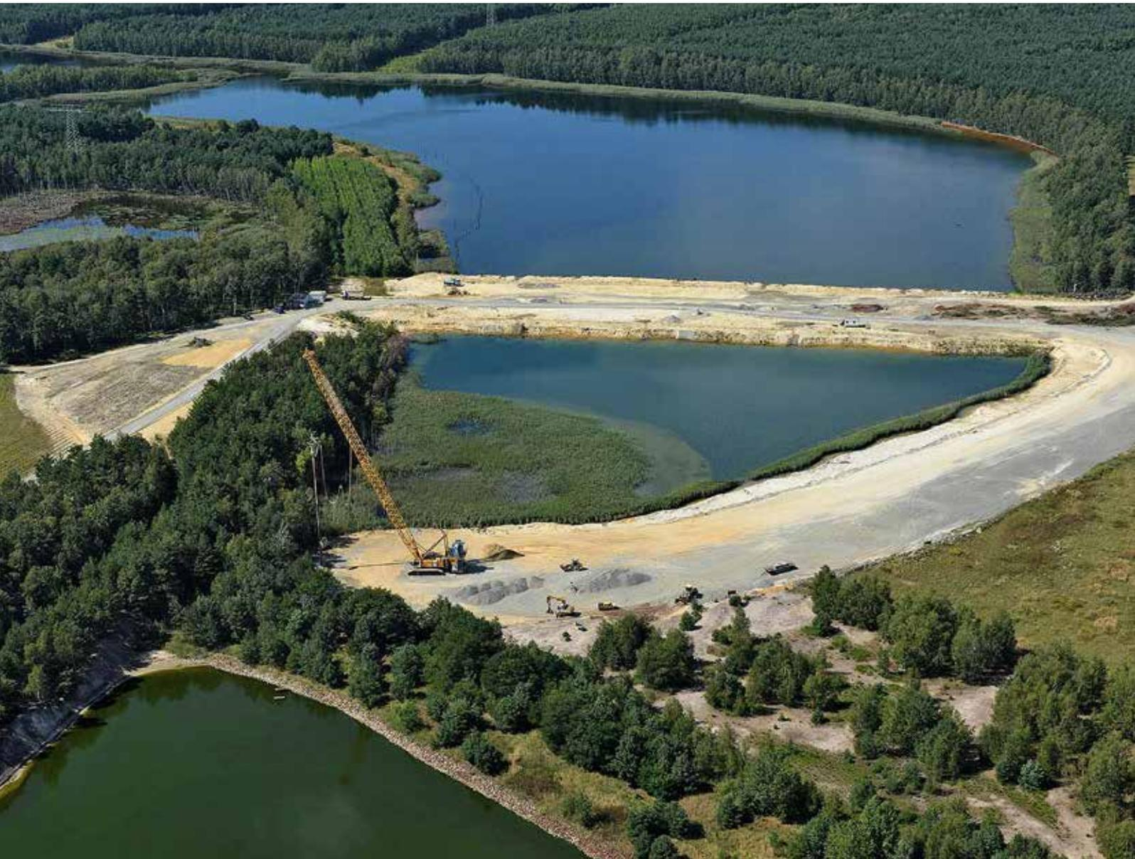
*Bergbauliche Sanierung in der Lausitz: Rütteldruckverdichten zur Dammsicherung am Restloch Heide VI*
