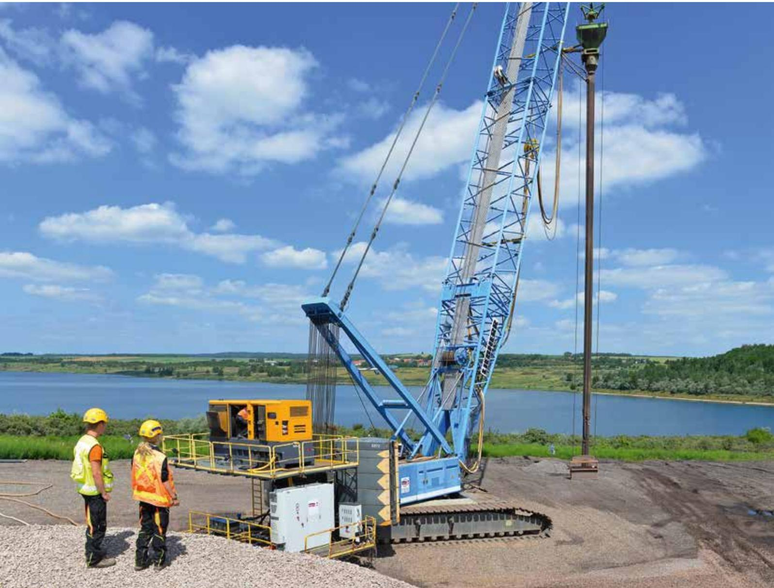
*Bewährte Technologie: Rüttelstopf-Verdichten am Tagebau Nachterstedt zum Sichern der Ufer des Concordia Sees*
