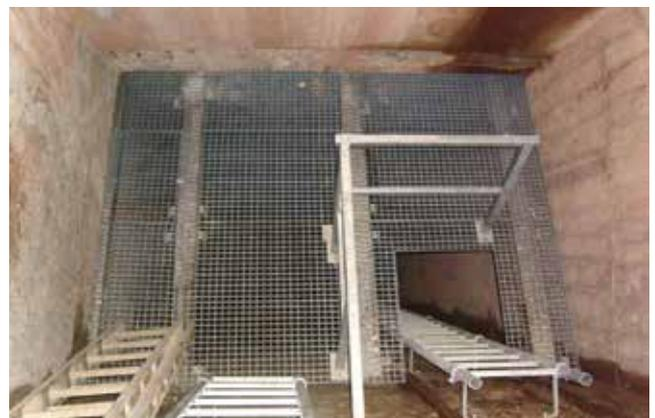
Zur Gewährleistung der öffentlichen Sicherheit der denkmalgeschützten Ruine des Römerschachtes wurde die Mauerkrone saniert sowie die offene Schachtröhre mit einer neuen, begehbaren Schachtabdeckung versehen (siehe Foto Seite 28 oben).
