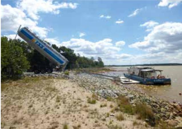
Mittels Rütteldruckverdichtung wurden auf einer Länge von insgesamt 1.200 Meter bis zu 125 Meter breite versteckte Dämme hergestellt.
