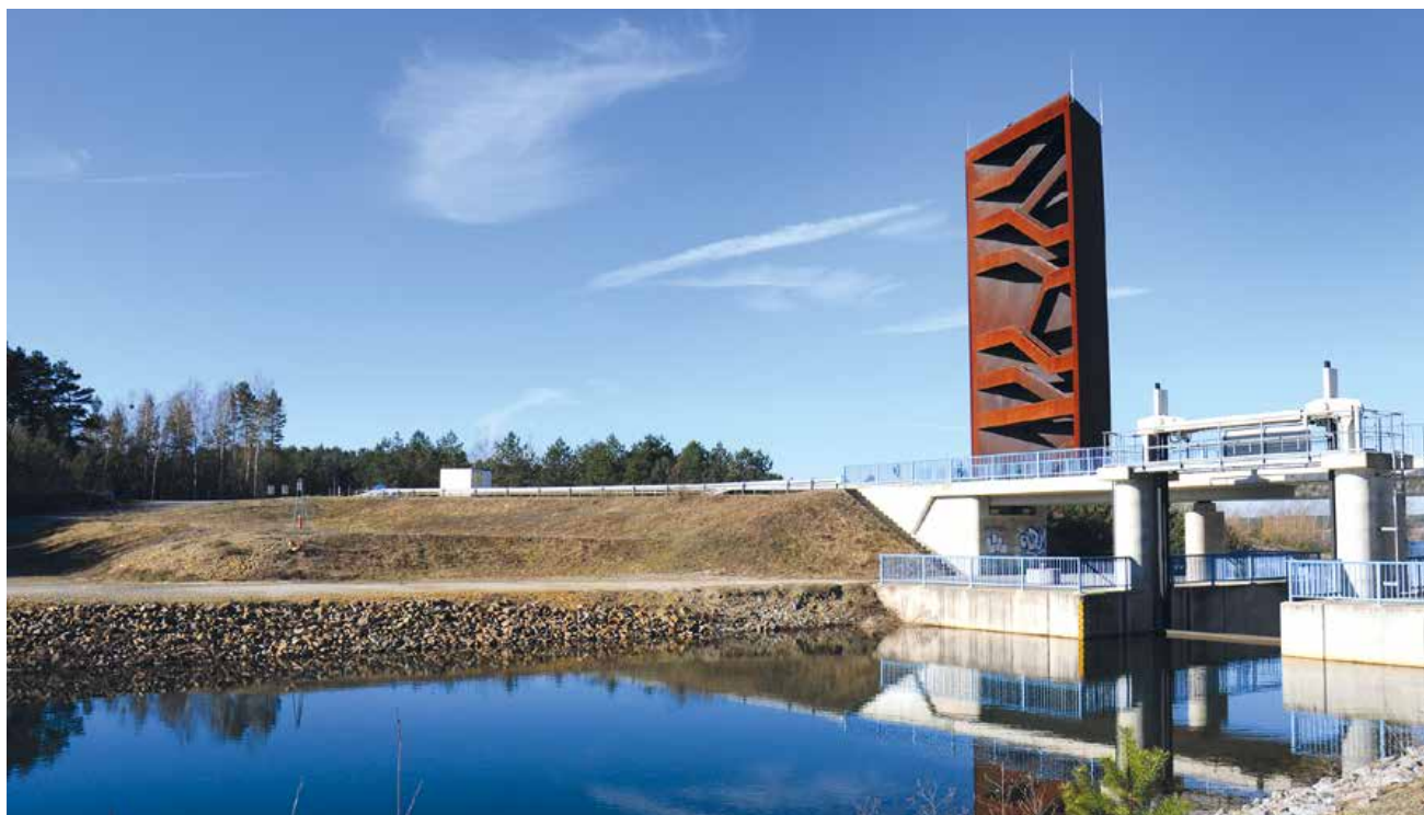
Sornoer Kanal mit Blick auf die Landmarke Rostiger Nagel
