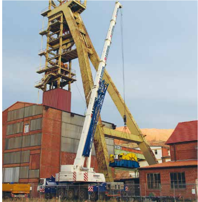
Fördergerüst vom Schacht II Bischofferode
