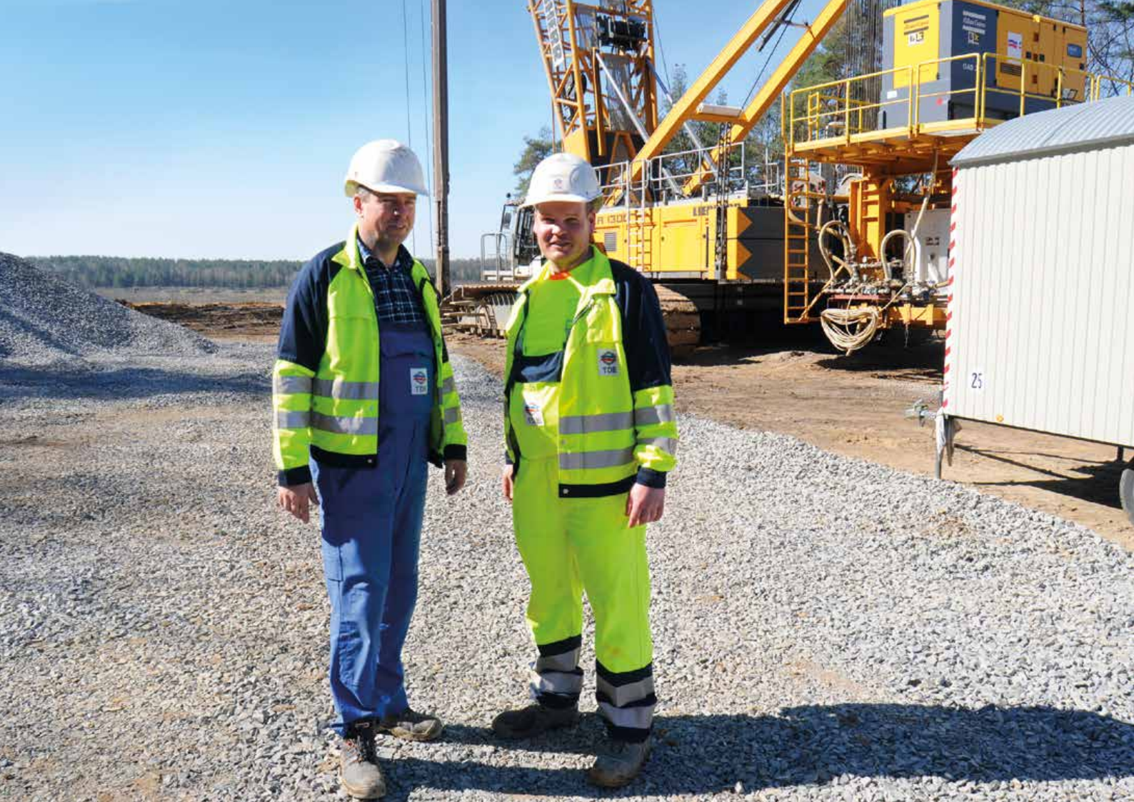
Mitarbeiter der Firma TDE bei der Rüttelstopfverdichtung am Restloch Marienteich
