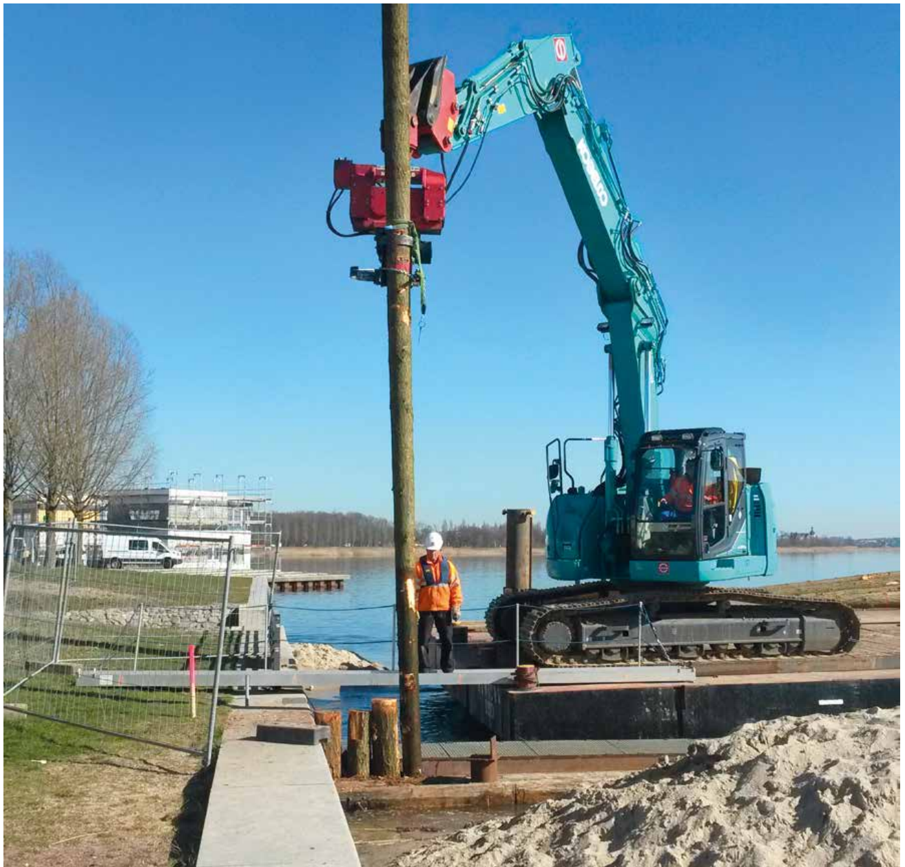
Errichten einer Mole am Ufer des Großen Goitzschesees
