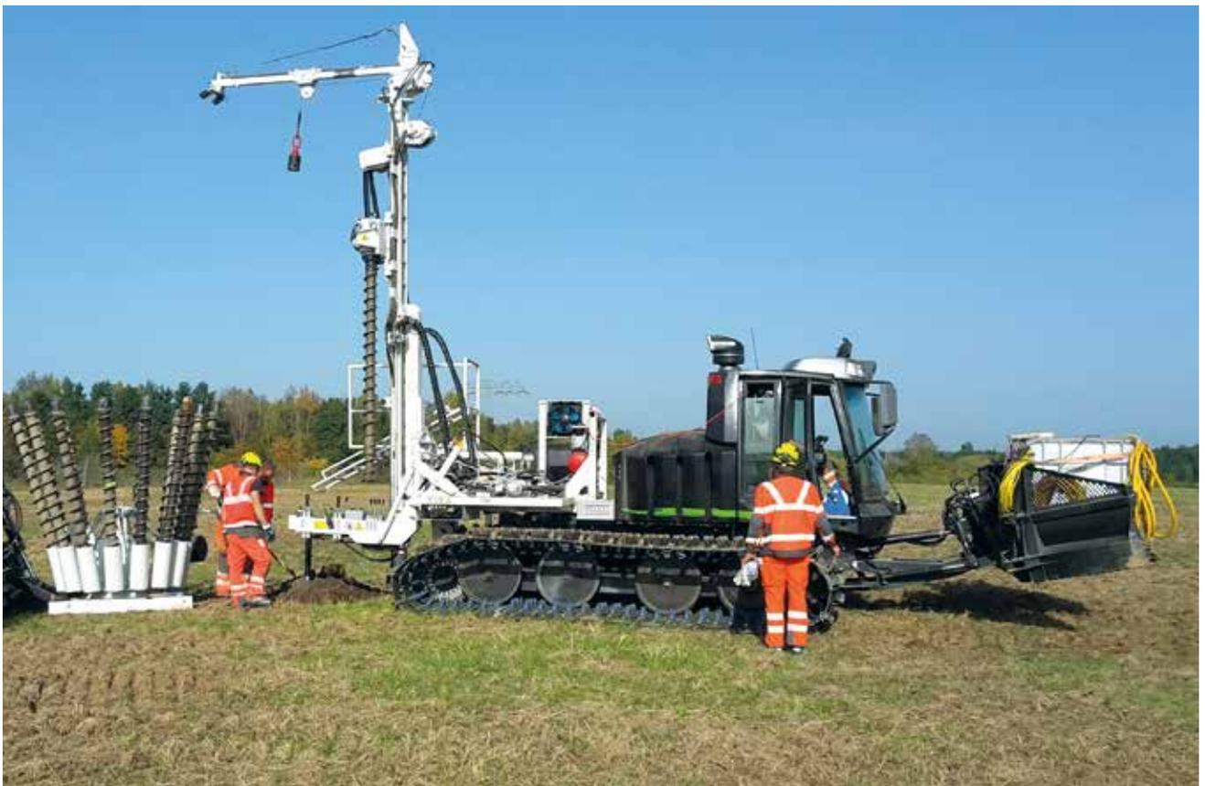
Leichte Bohrtechnik auf einer Pistenraupe zur Durchführung der schonenden Sprengverdichtung
