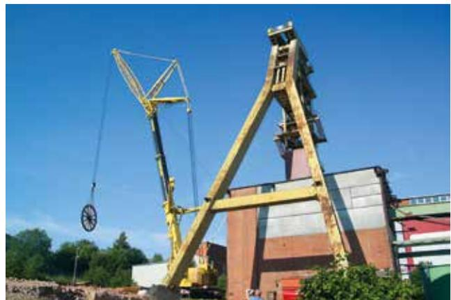
Demontage einer der Seilscheiben des Fördergerüsts am Schacht 2 des Bergwerkes Bischofferode
