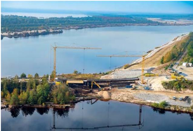
Beide Brückenwiderlager und das Traggerüst für den Brückenüberbau wurden ebenfalls fertiggestellt.
