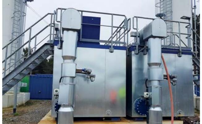
wurde die Anlage am 24. Juni 2019 in den Einfahrbetrieb genommen. Mit der Anlage wird eisenbelastetes Grundwasser gereinigt und anschließend wieder in die Spree eingeleitet.
