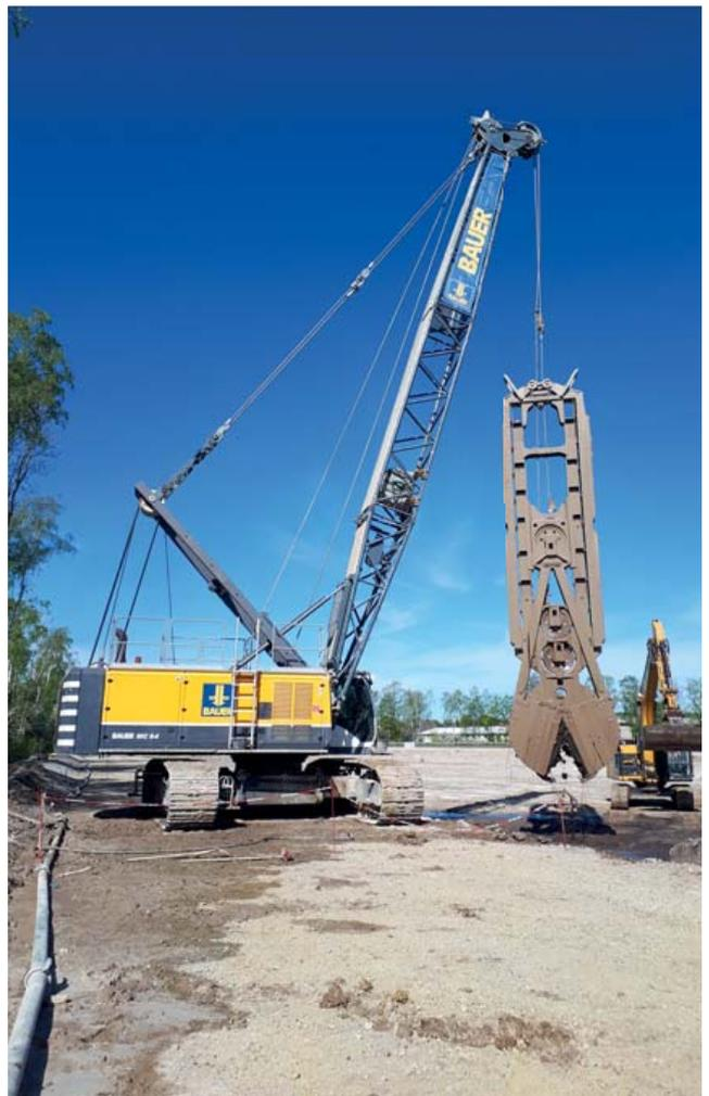
Ein Seilbagger mit Schlitzwandgreifer baut die Dichtwand ein.
